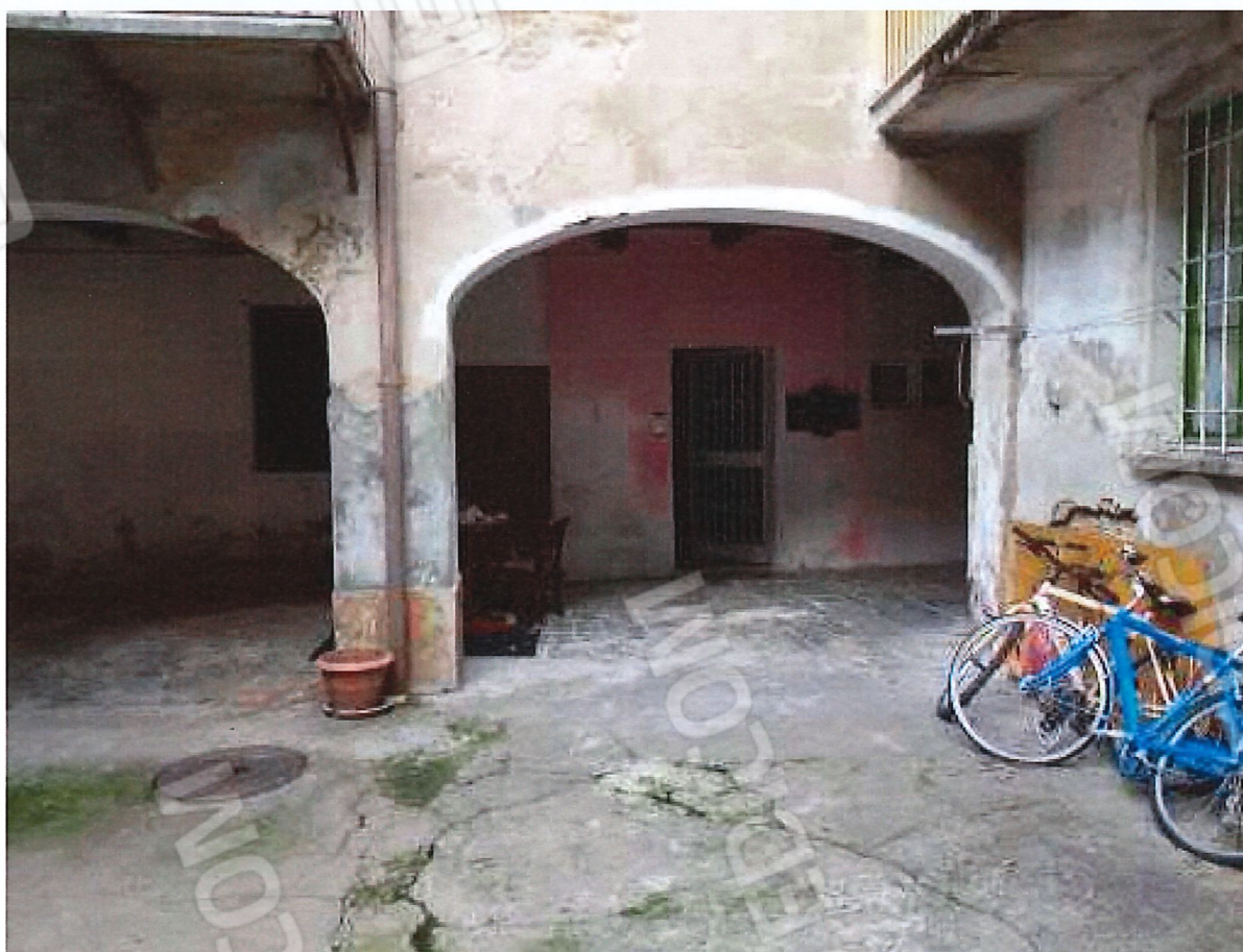
Vista del cortile interno di proprietà comune
