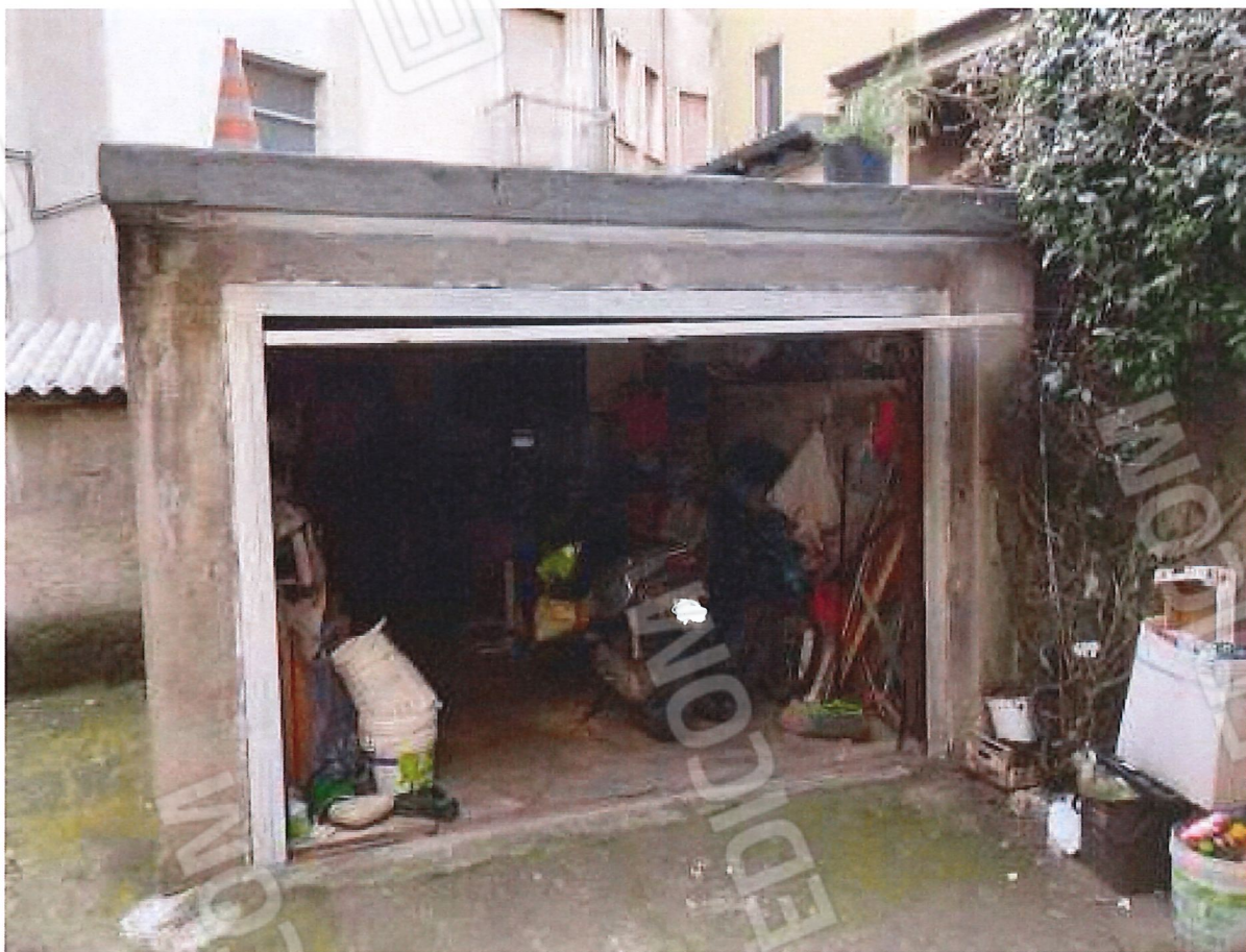
Vista dell' autorimessa
