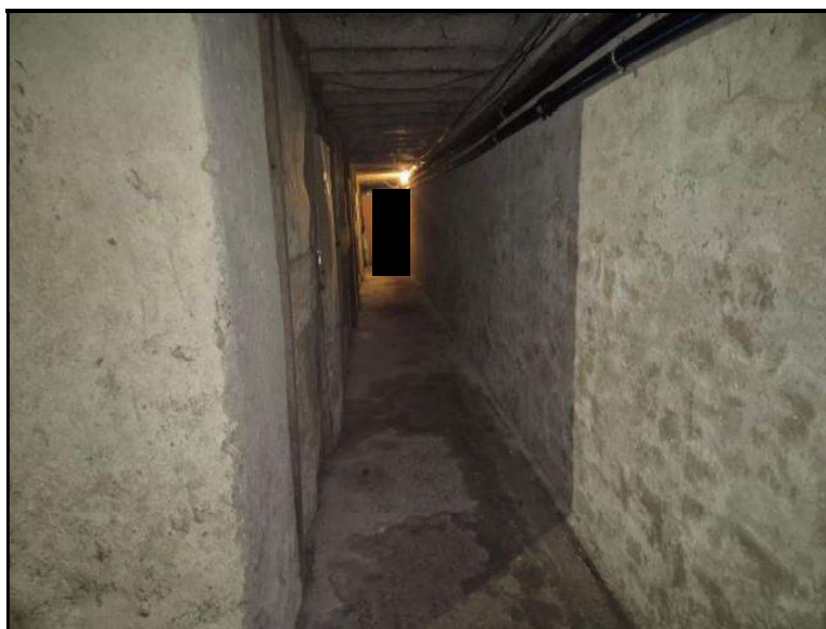
FOTO 27 ALTRA VISTA DISIMPEGNO DI DISTRIBUZIONE CANTINE AL PIANO PRIMO SOTTOSTRADA.
