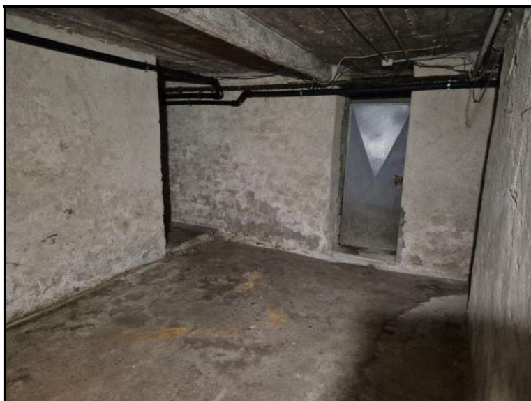
FOTO 26 VISTA DISIMPEGNO DI DISTRIBUZIONE CANTINE AL PIANO PRIMO SOTTOSTRADA.
