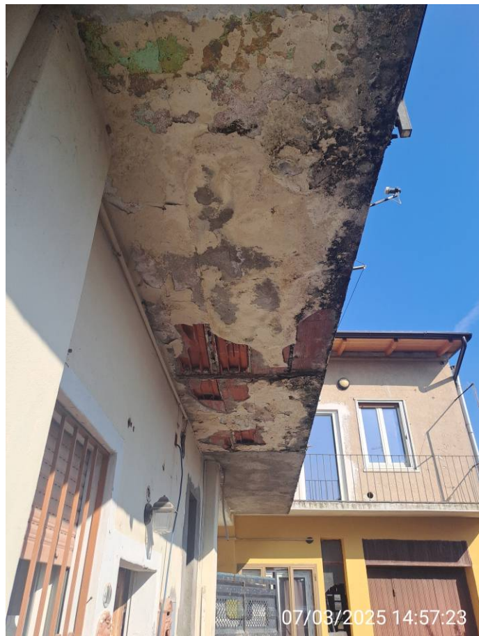
Foto 11 e 12 – Stato di degrado sotto balcone / ballatoio
