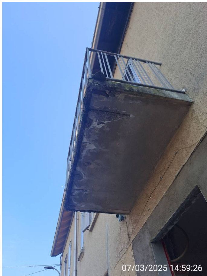
Foto 11 e 12 – Stato di degrado sotto balcone / ballatoio
