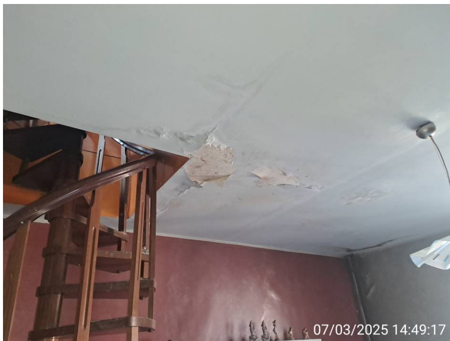
Foto 9 – Infiltrazioni da copertura
