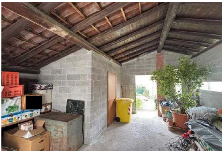
tettoia in corpo esterno - interno
