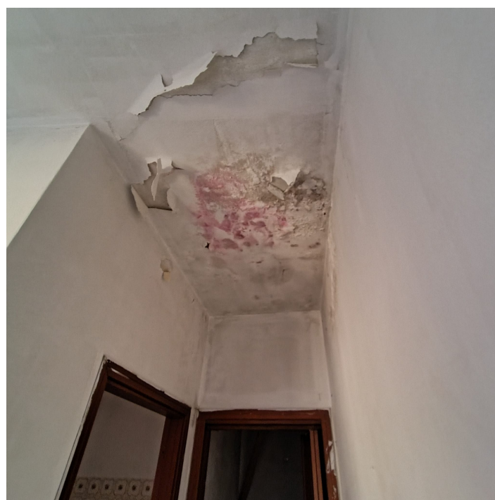
DISIMPEGNO PIANO PRIMO
