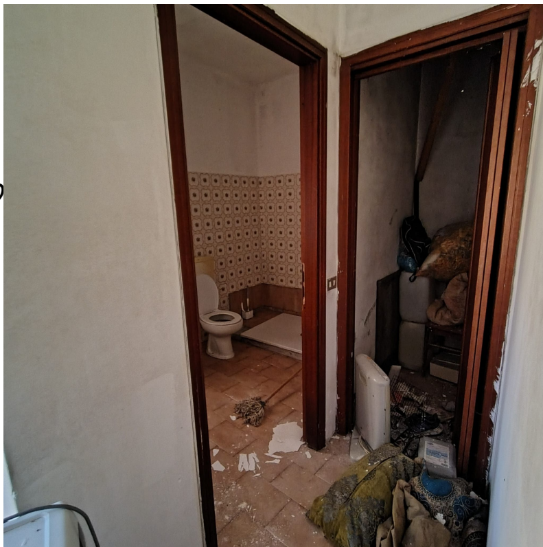
DISIMPEGNO PIANO PRIMO
