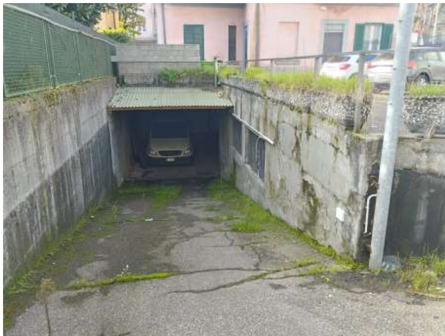
RAMPA DI ACCESSO CARRAIO ALL'IMMOBILE
