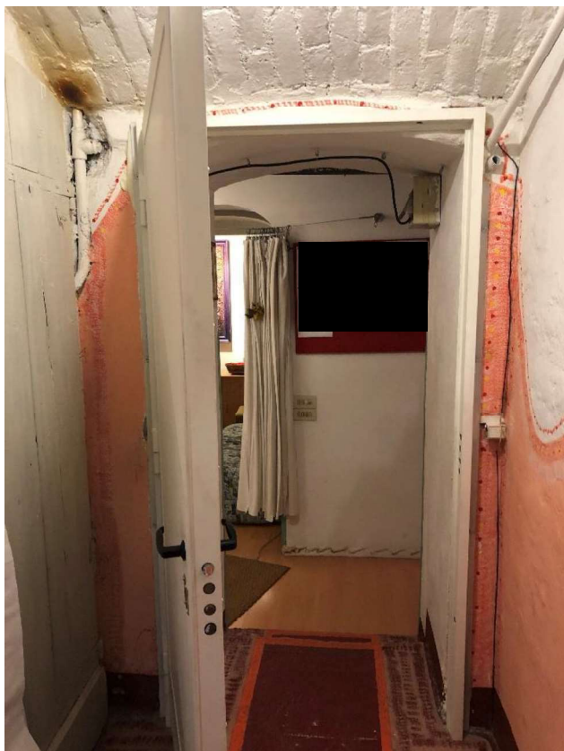
Vista disimpegno d'ingresso
