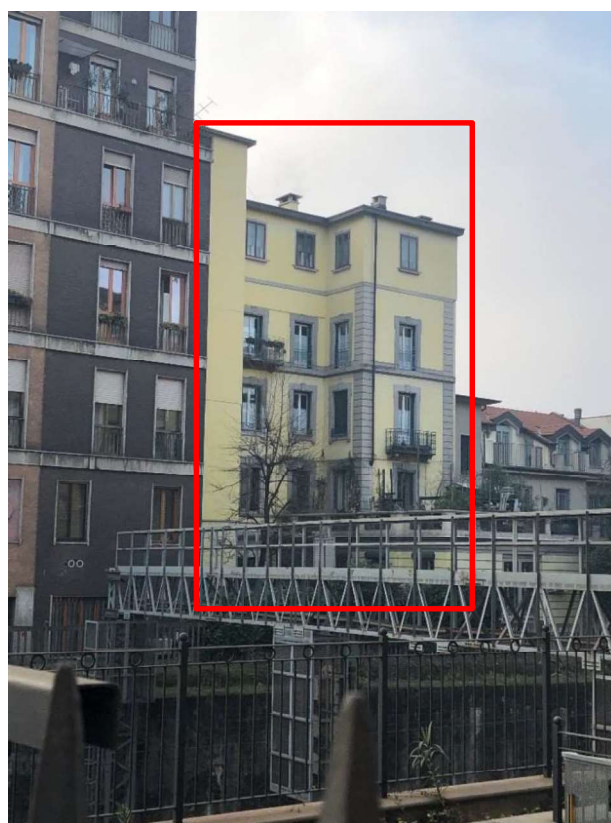
vista dal retro del fabbricato
