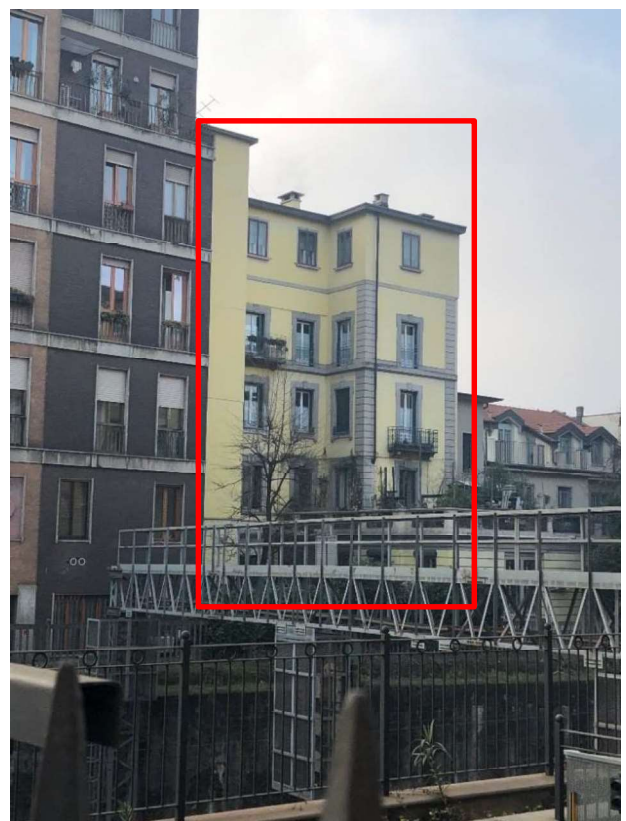
vista dal retro del fabbricato
