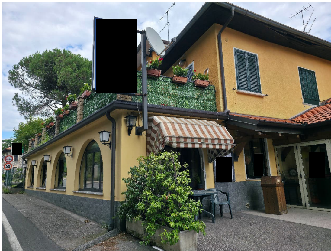
Foto 3 – Vista strada – Via Guglielmo Marconi.
