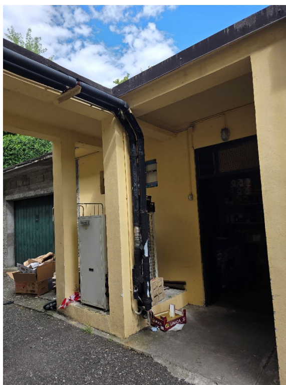
Foto 2 - Vista accesso magazzino 4385 sub.1.
