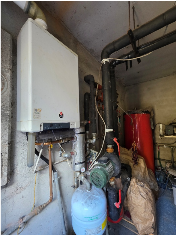
Foto 9 - Locale tecnico impianto termico con caldaia a gas in condensazioni.
