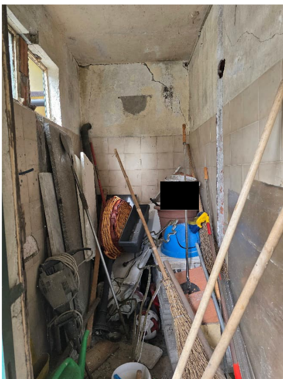
Foto 3 – interno vano ripostiglio con accesso esterno
