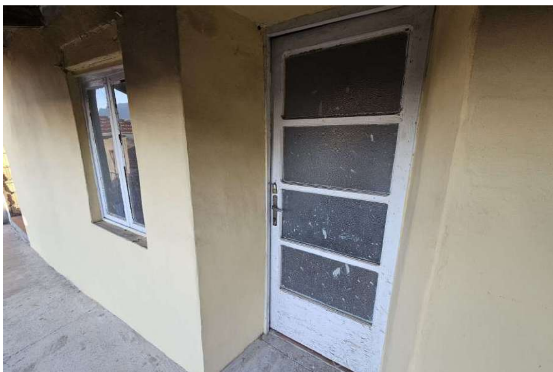
Particolare dei serramenti
