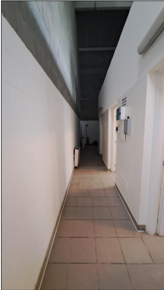
Piano terra disimpegno zona spogliatoi
