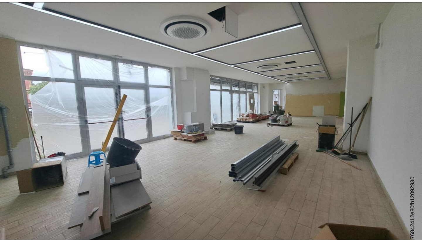
Piano terra ex ristorante/bar
