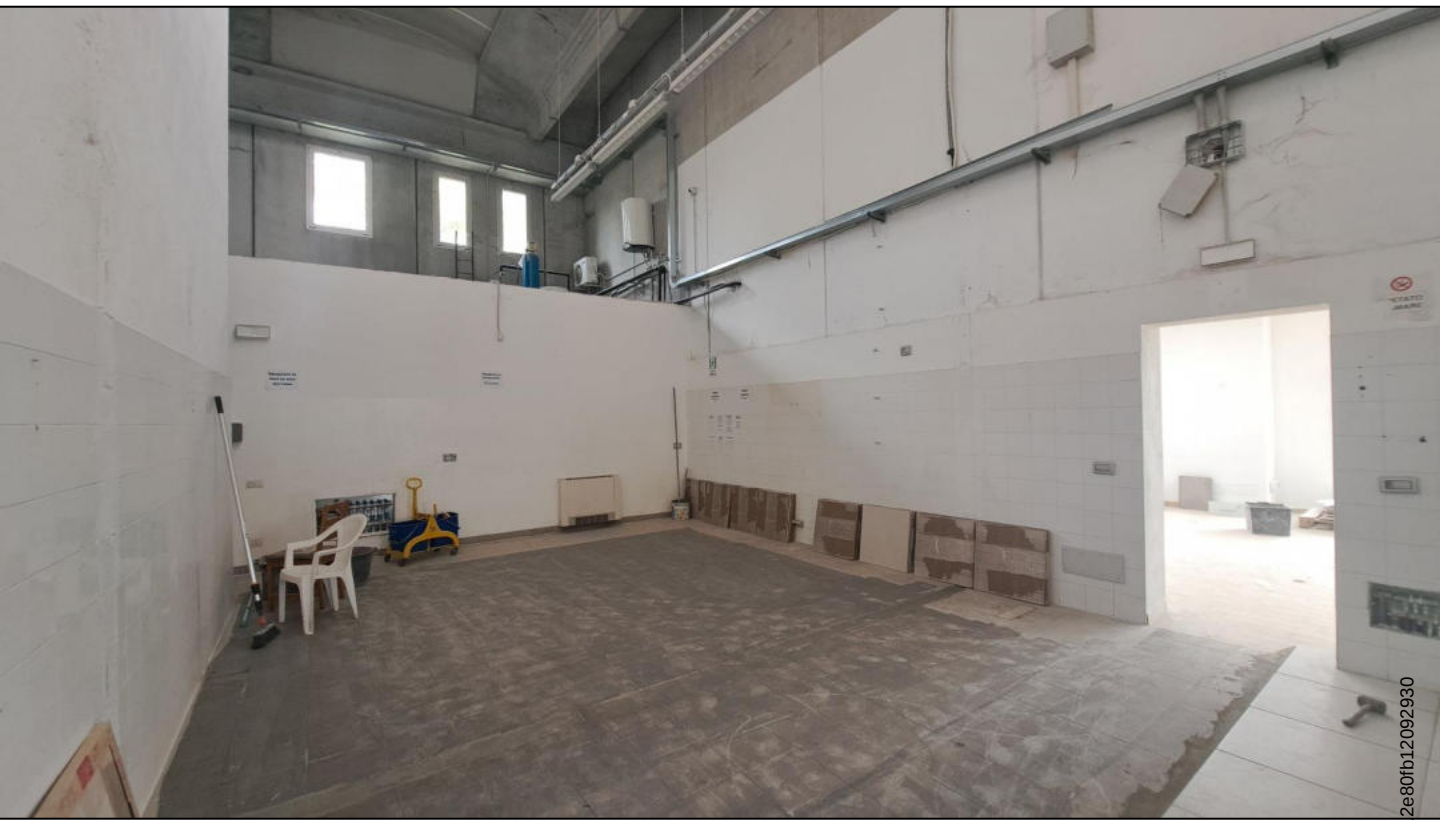
Piano terra ex zona cucina
