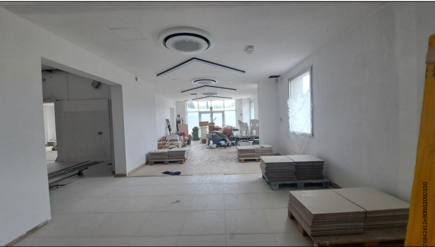
Piano terra ex ristorante/bar
