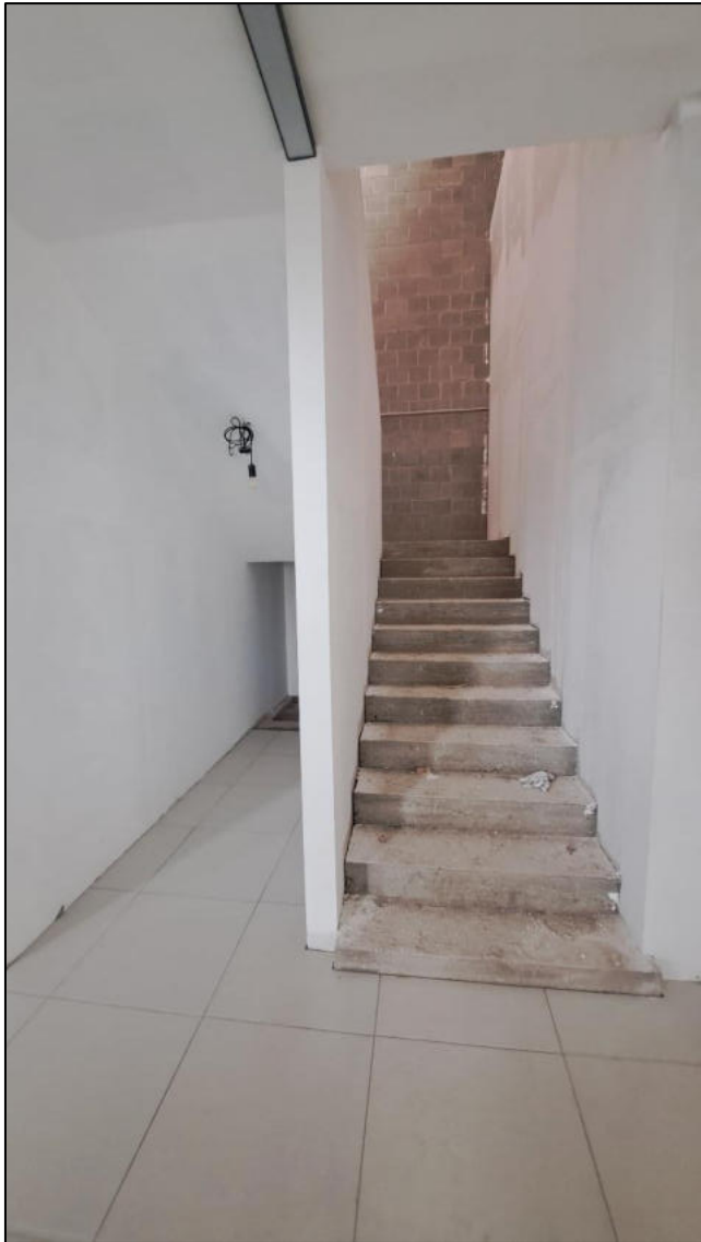
Scala di accesso al soppalco
