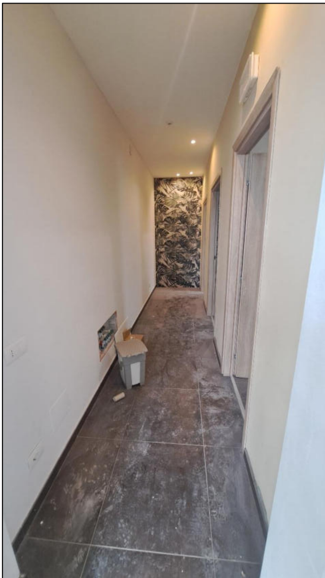
Piano terra disimpegno zona servizi
