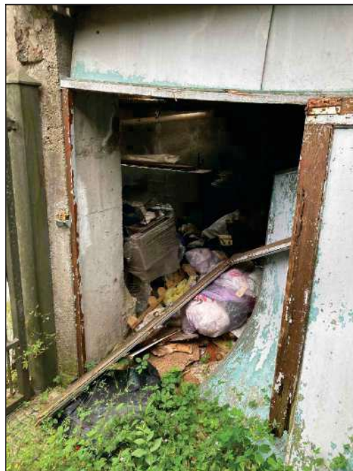
Foto 10 - ACCESSO LOCALE DEPOSITO (RUSTICO) PART. 1338-1872
