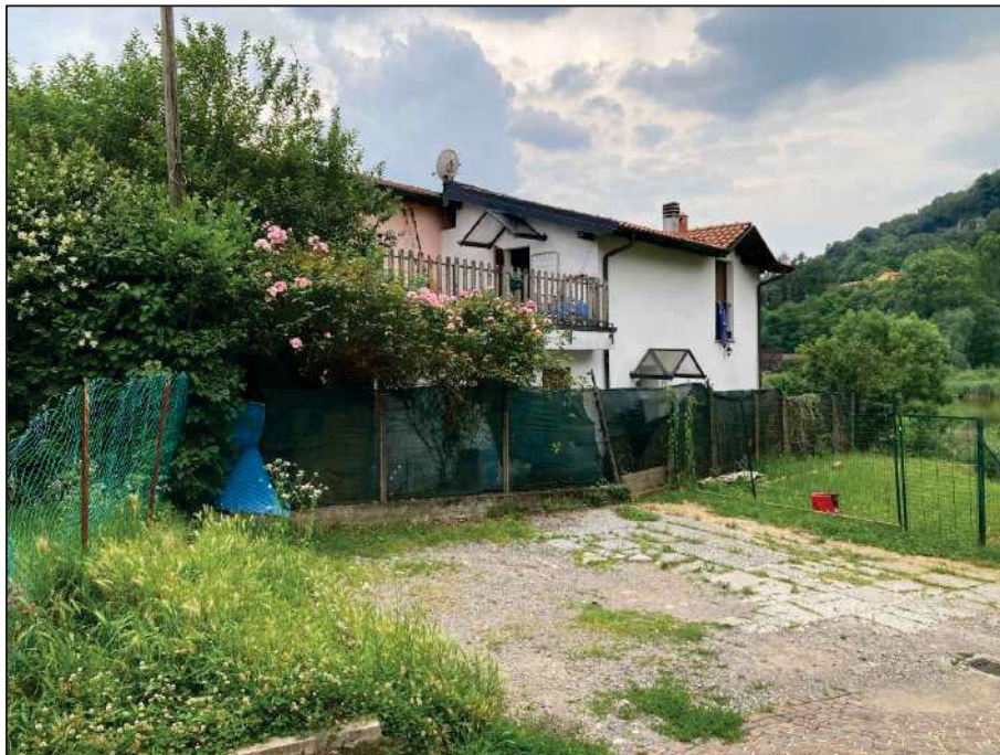
Foto 11 - VISTA IMMOBILE DA SUD-OVEST
