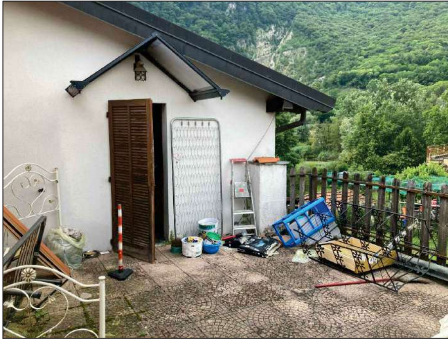
Foto 25 - TERRAZZO, FINESTRA CAMERA
