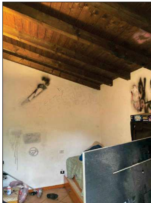
Foto 24 - CAMERA, DETTAGLIO SOFFITTO
