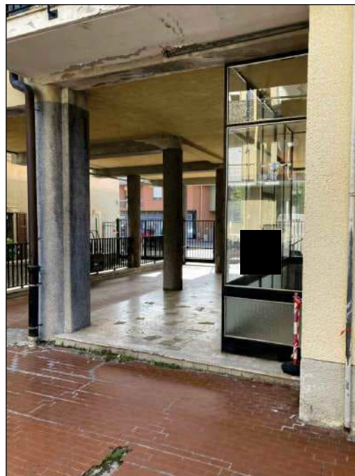
Foto 13 - VISTA PORTICO DA EST
