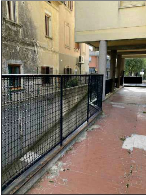
Foto 7 - VISTA PORTICO DA EST
