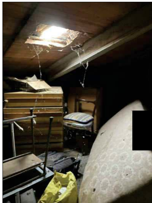
Foto 38 - SOFFITTA NEL SOTTOTETTO
