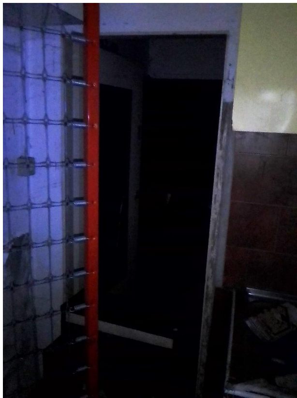
FOTO 21 – LOCALI INTERNI PIANO TERRA
