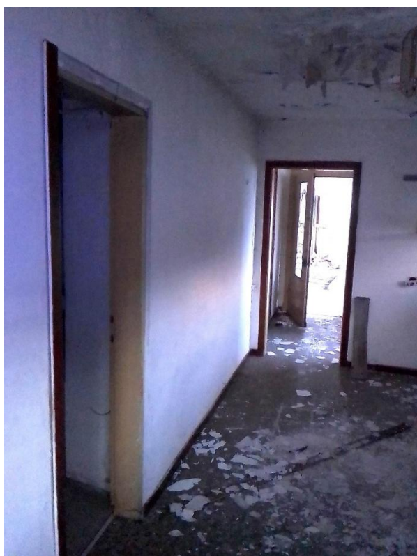
FOTO 14 – LOCALI INTERNI PIANO PRIMO
