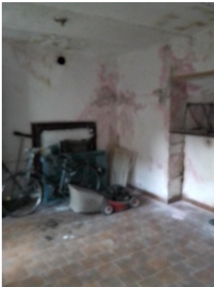
FOTO 11 – LOCALE SGOMBERO PIANO TERRA
