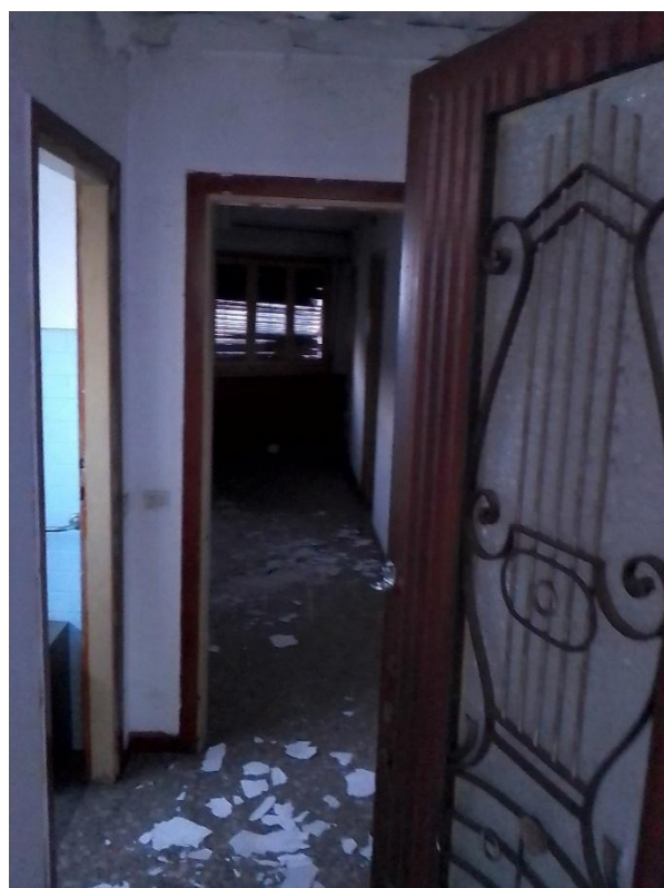
FOTO 15 – LOCALI INTERNI PIANO PRIMO
