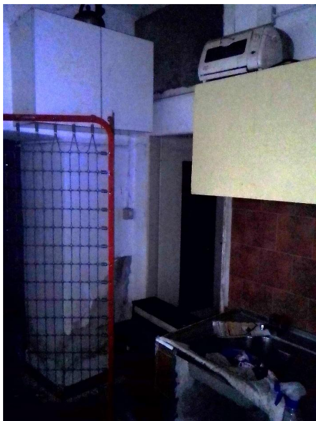
FOTO 20 – LOCALI INTERNI PIANO TERRA
