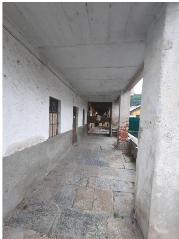
FOTO 3 – VISTA PORTICO PIANO TERRA
