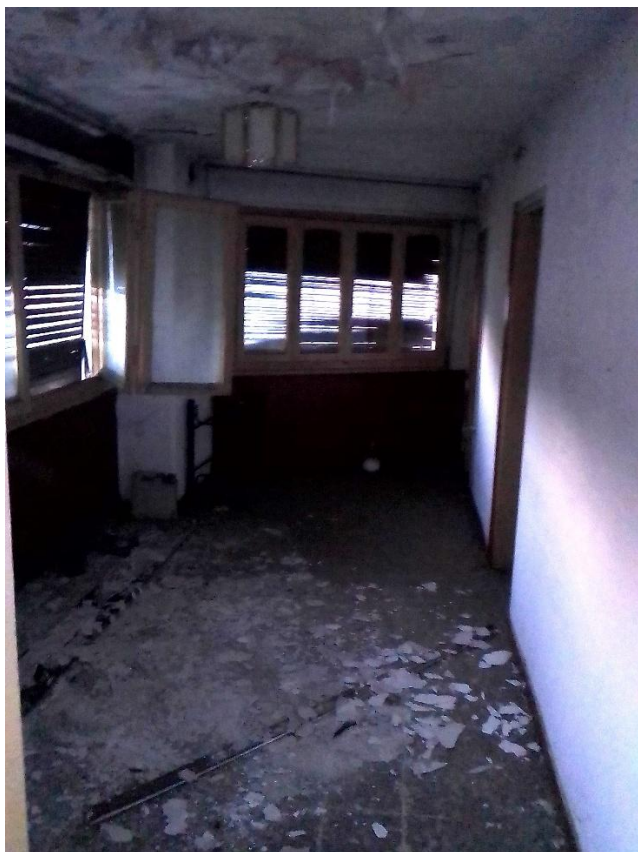
FOTO 12 – LOCALI INTERNI PIANO PRIMO
