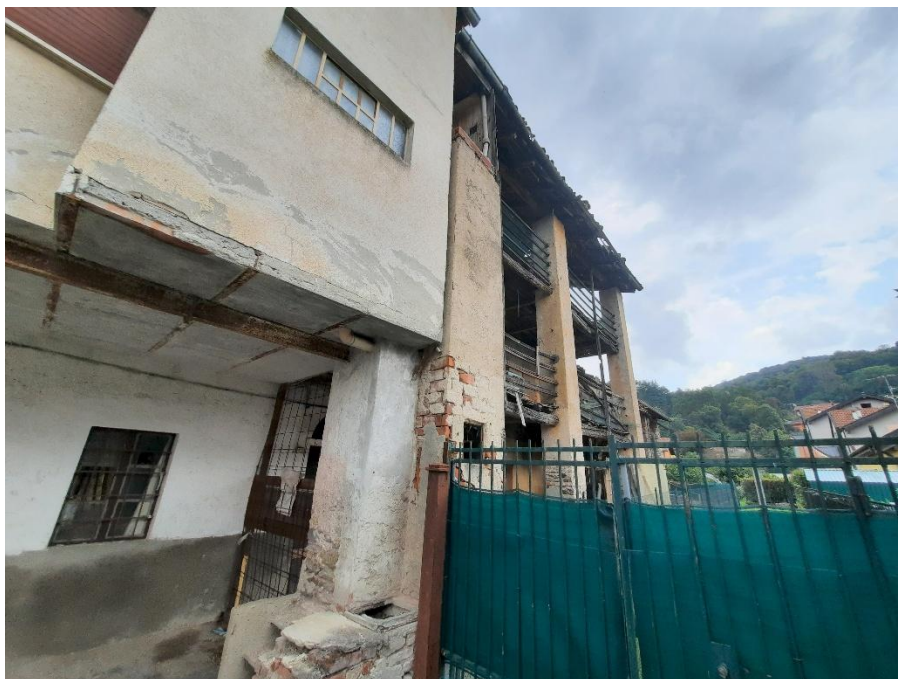
FOTO 5 – VISTA DAL CORTILE INTERNO
