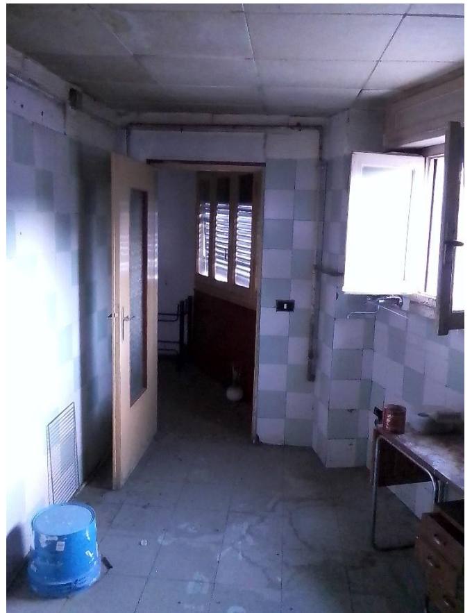
FOTO 17 – LOCALI INTERNI PIANO PRIMO
