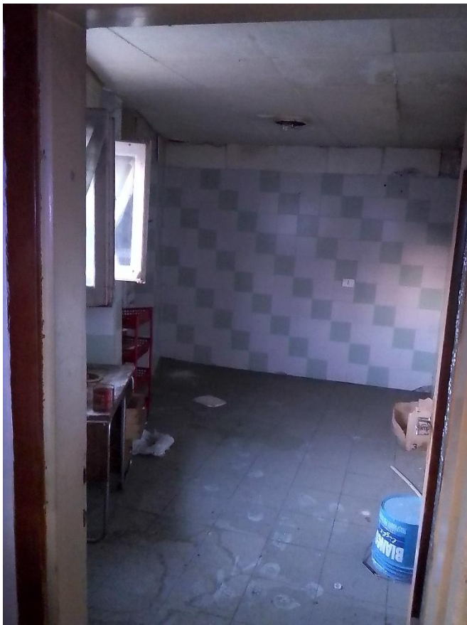
FOTO 16 – LOCALI INTERNI PIANO PRIMO
