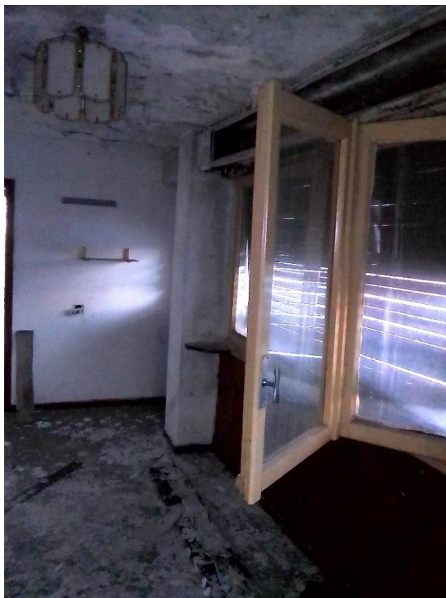
FOTO 13 – LOCALI INTERNI PIANO PRIMO
