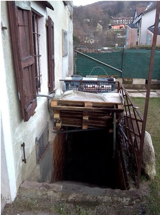
FOTO 4 – ACCESSO A CANTINA INTERRATA
