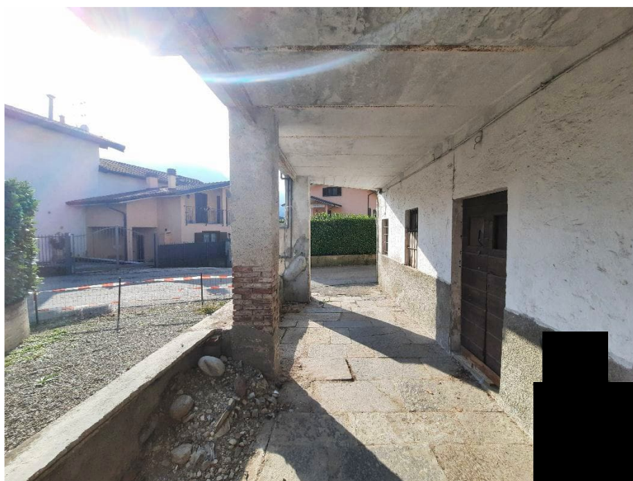
FOTO 4 – VISTA PORTICO PIANO TERRA
