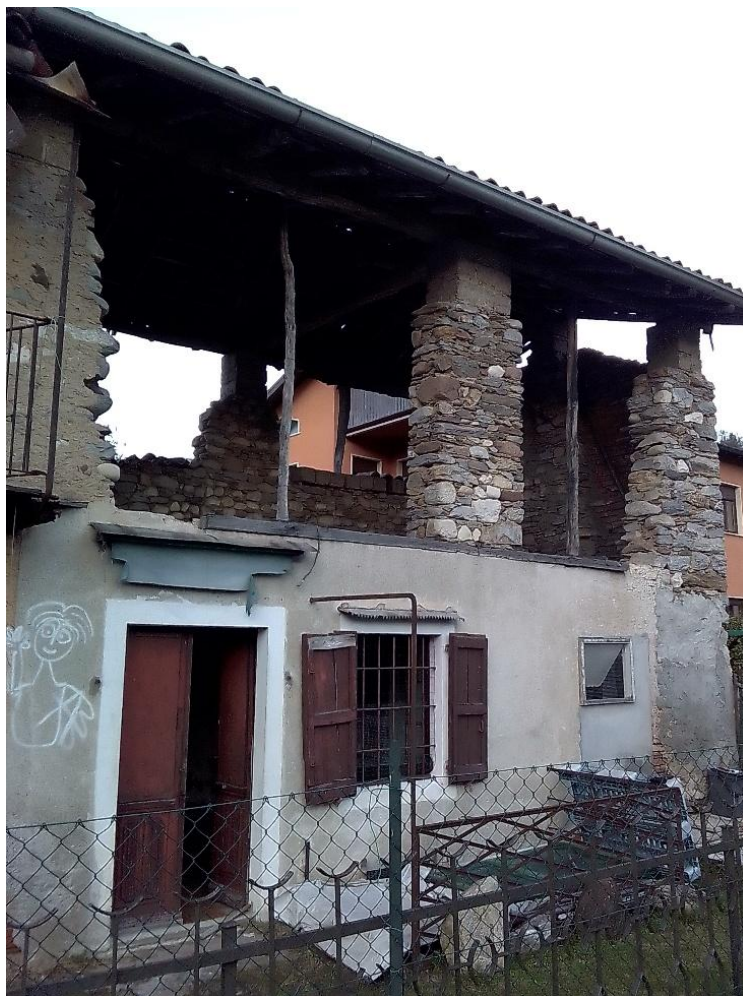
FOTO 3 – VISTA DALL'ESTERNO LEGNAIA/SGOMBERO DA CORTILE INTERNO
