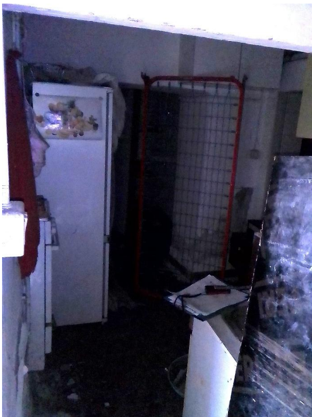
FOTO 19 – LOCALI INTERNI PIANO PRIMO
