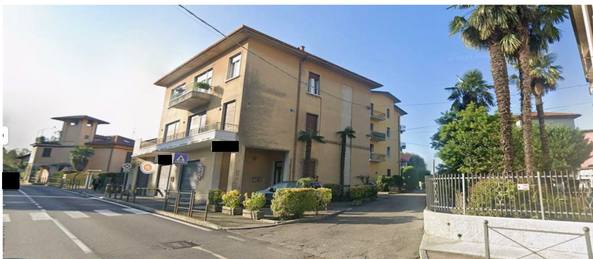
Prospetto su Via Morazzone
