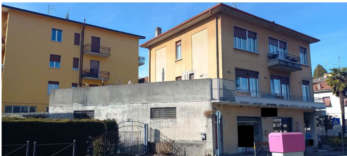
Prospetto su Via Morazzone
