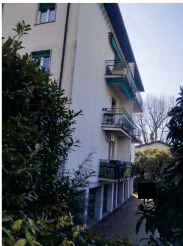
VISTA FABBRICATO DAL CORTILE INTERNO
