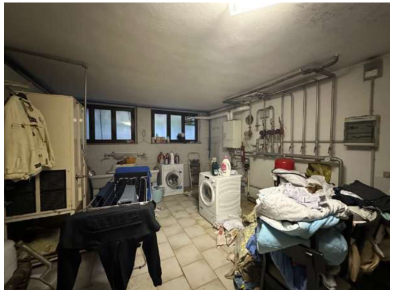
deposito 3 sub.502 Zona A
