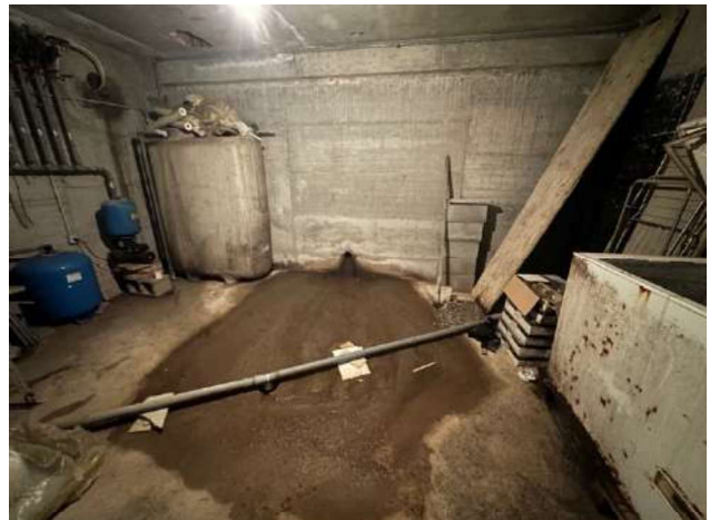
deposito 3 sub.502 Zona B
