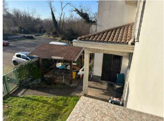
BCNC sub.1 Portico comune ingresso
