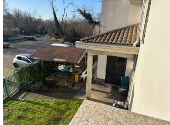
BCNC sub.1 Portico comune ingresso
