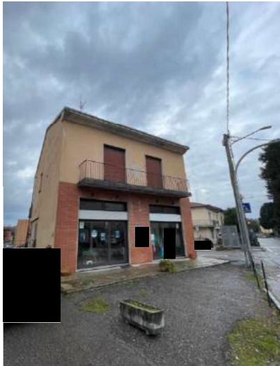
Foto 1 - prospetto fabbricato lato nord
