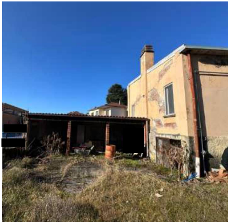
Foto 3 - prospetto fabbricato lato ovest
