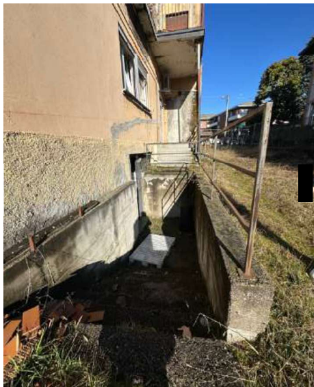
Foto 5 – accesso al piano seminterrato
