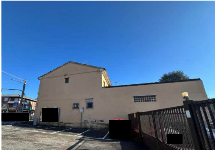
Foto 2 - prospetto fabbricato lato est
