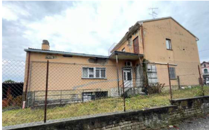
Foto 4 - prospetto fabbricato lato est
