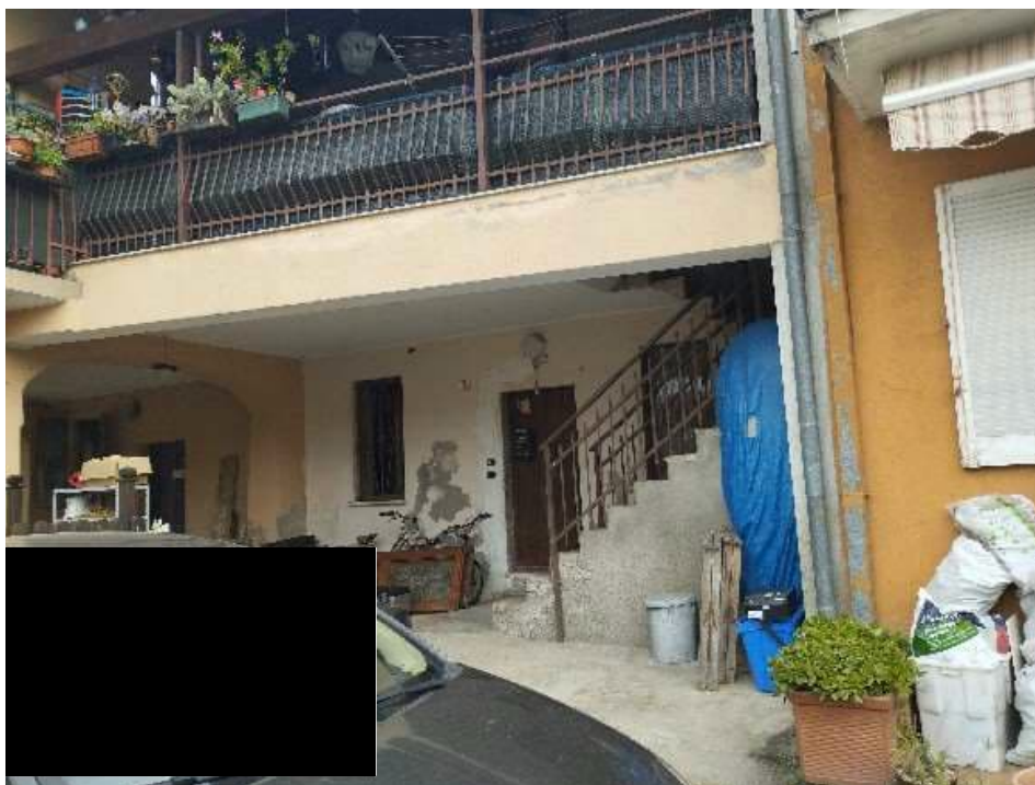
UNITA'VISTA DAL CORTILE
