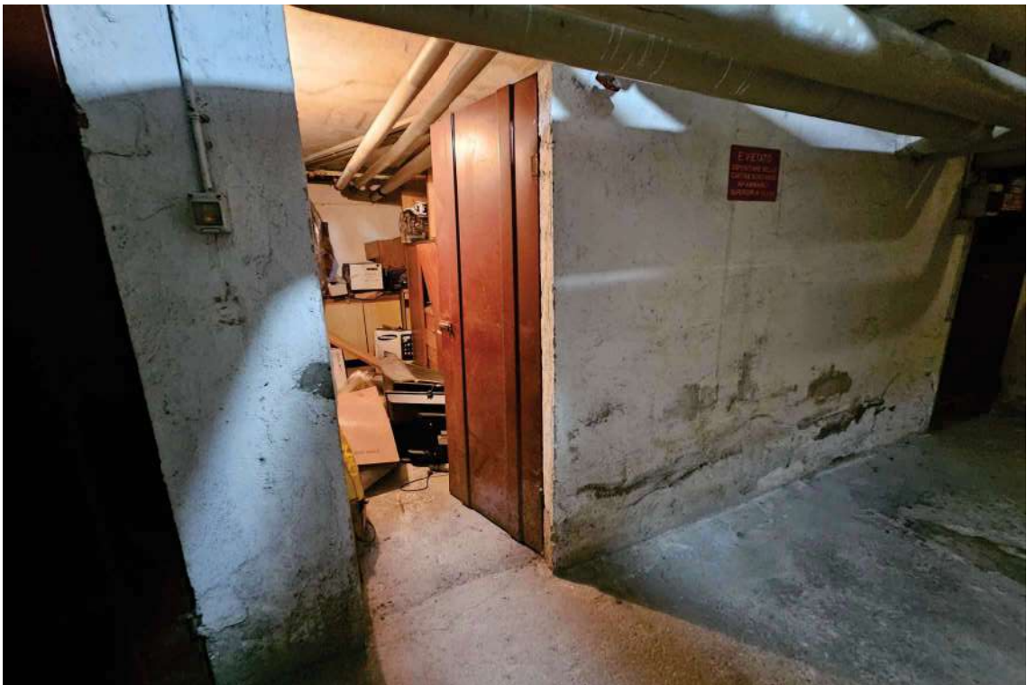
Vista del locale cantina al piano interrato
