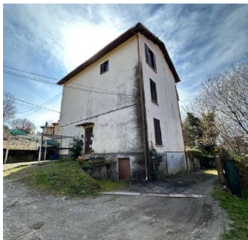
Foto 3 - prospetto fabbricato lato nord-ovest
