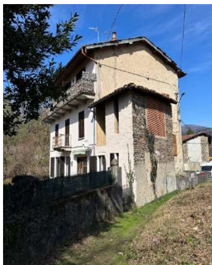
Foto 5 – prospetto fabbricato lato sud-est
