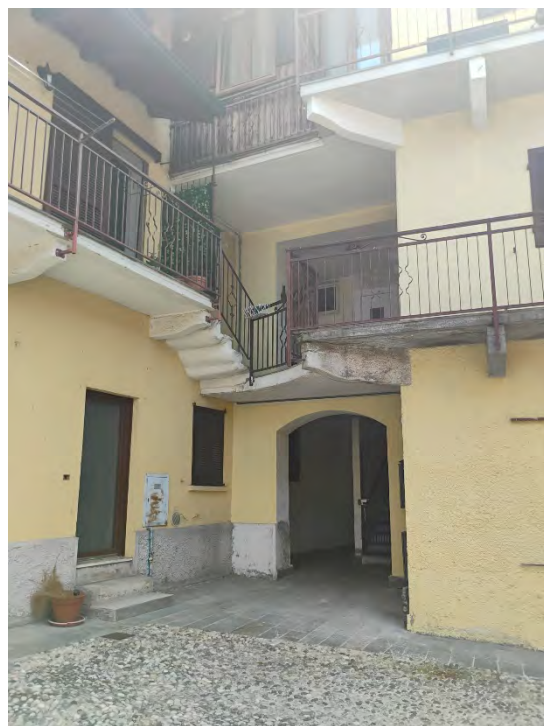
Particolare androne altro ingresso
