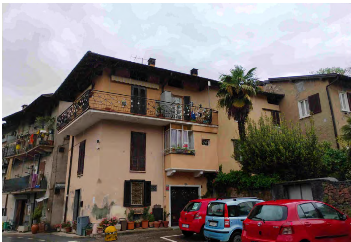
Vista abitazione al p.t., p.1, p.2 e ingresso box auto al p.t.
