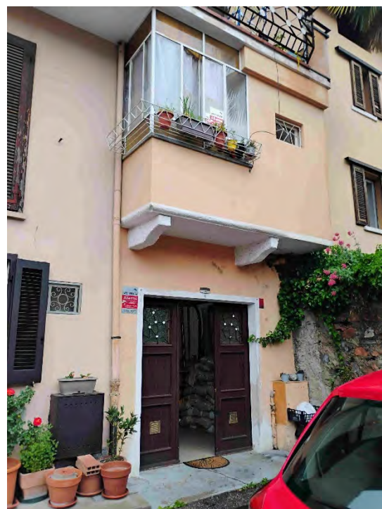
Particolare altro ingresso lato box
