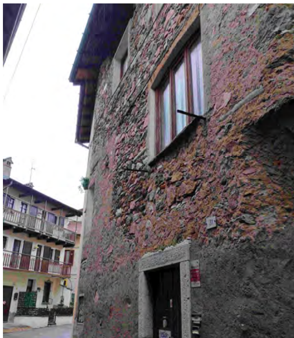
Facciata principale – ingresso principale
