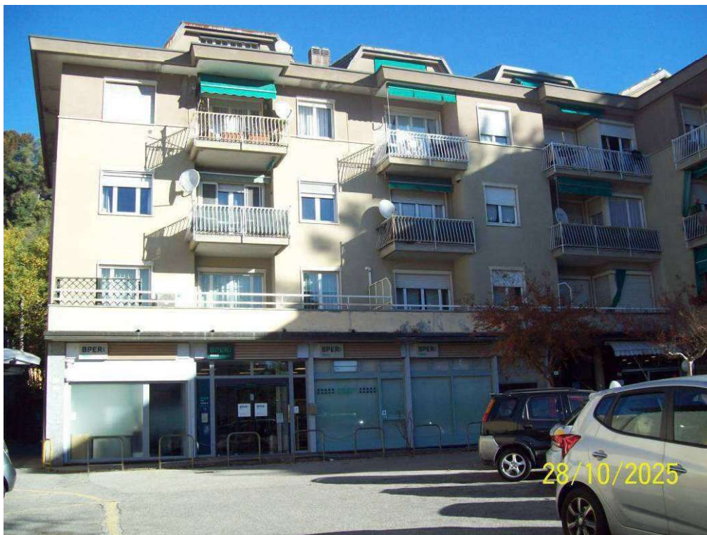
FOTO 1 - prospetto edificio su piazza
