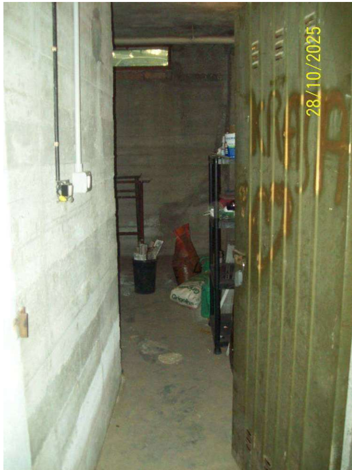
FOTO 12 – cantina piano interrato “lotto 1 corpo A”
