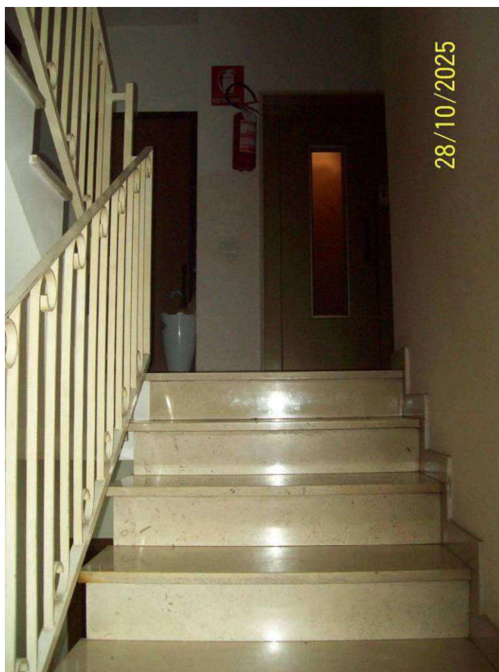
FOTO 2 – vano scala accesso abitazione “lotto 1 corpo A”
