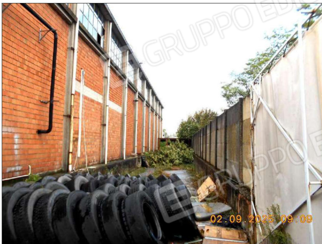
Figura 9 – vista esterna dell'area a Nord comune alle unità immobiliari
