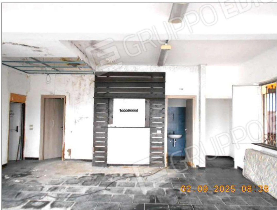
Figura 31 – vista interna dei particolari costruttivi dei locali al piano rialzato
