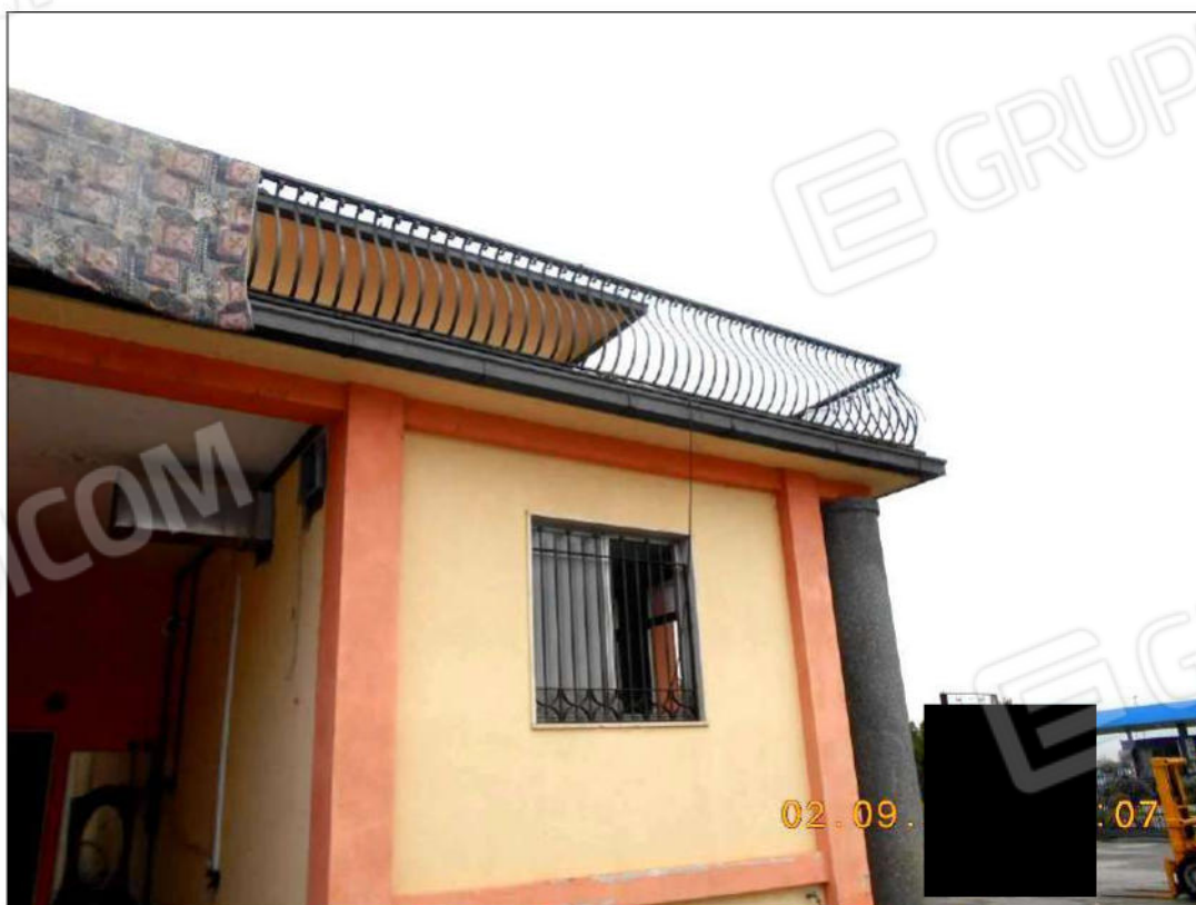
Figura 18 – vista esterna del fronte Sud dei locali di servizio con particolari costruttivi
