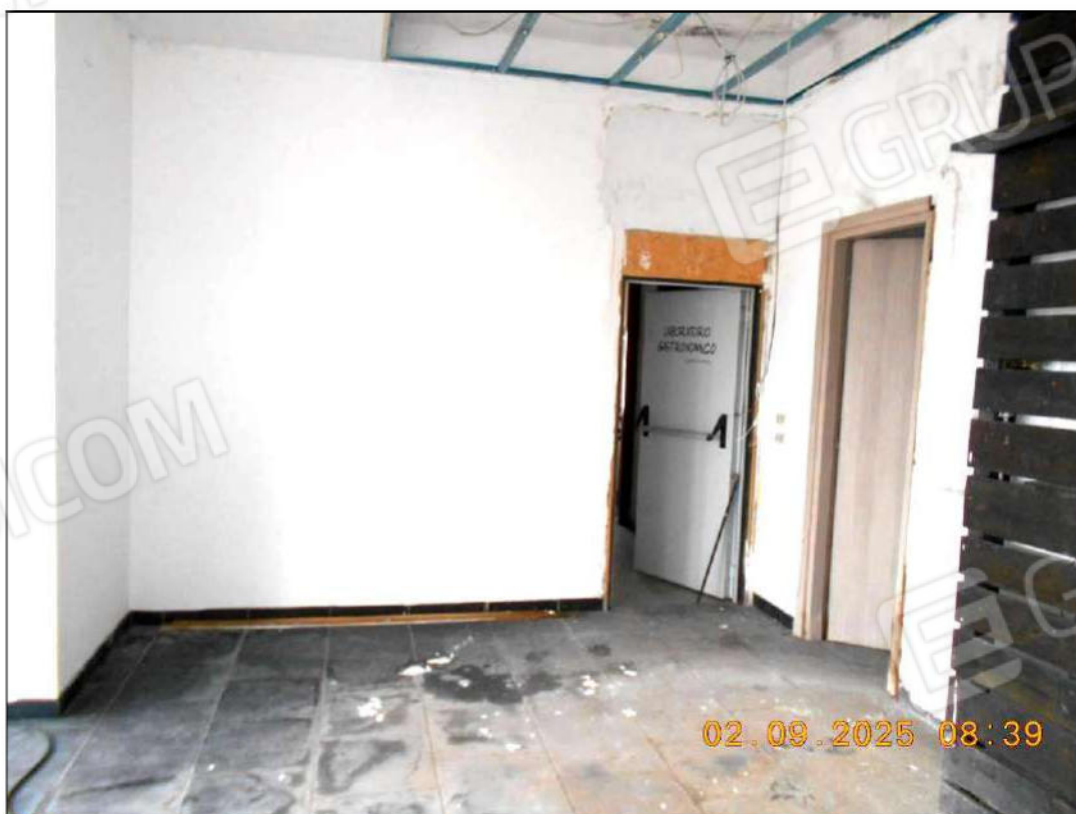
Figura 34 – vista interna dei particolari costruttivi dei locali al piano rialzato
