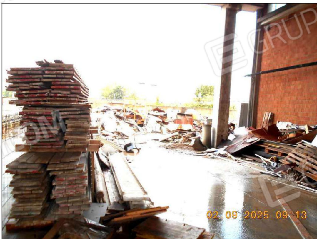
Figura 12 – vista interna della tettoia a ridosso del fronte Sud
