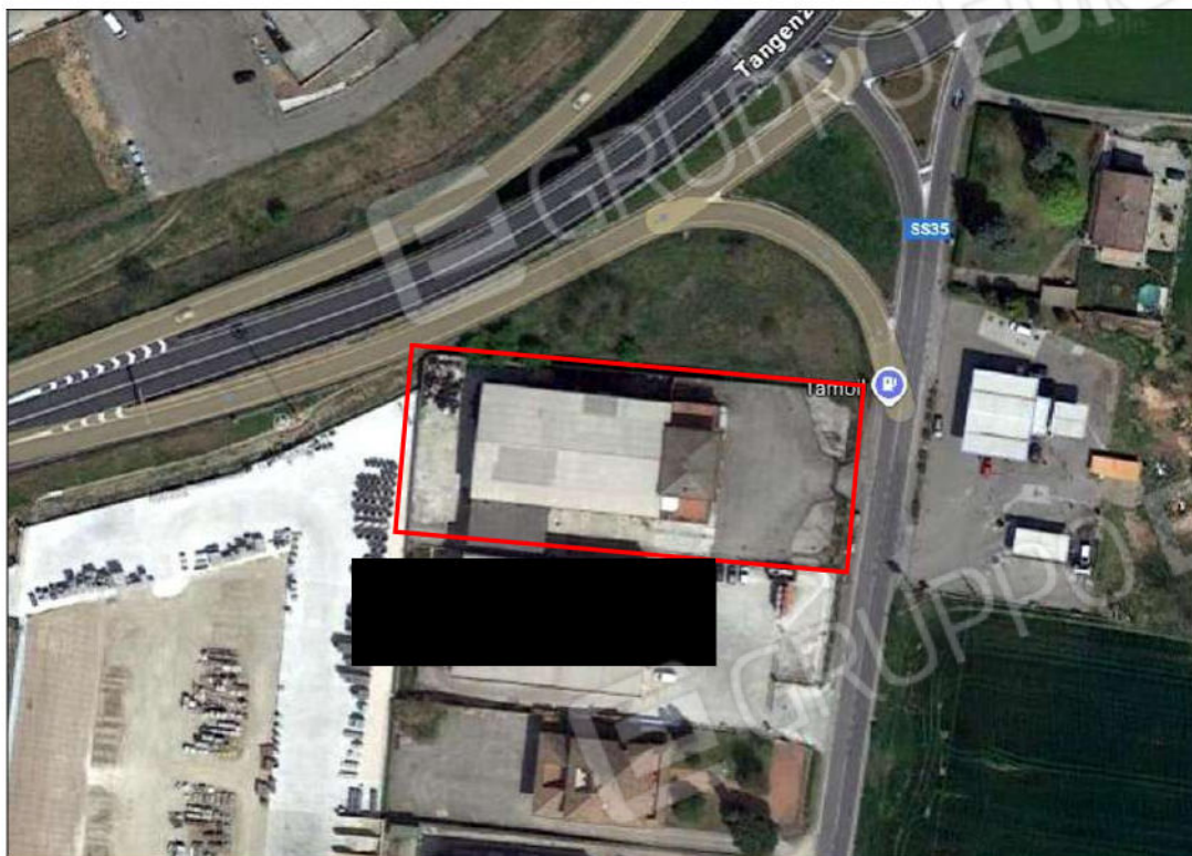
Figura 1 – vista aerea del complesso immobiliare
