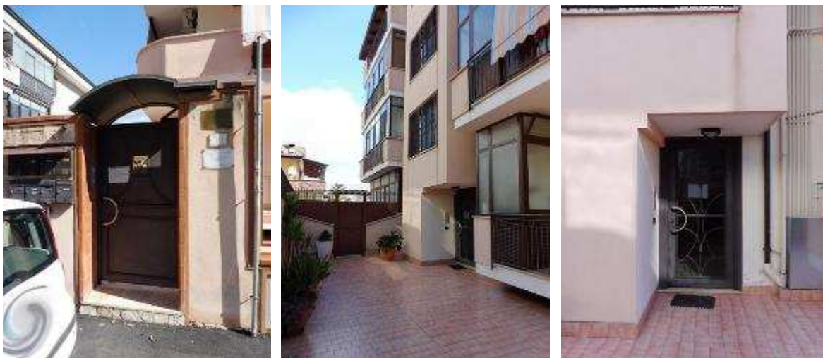
_immagini esterne –accesso al fabbricato da via De André e al vano scala da area condominiale
