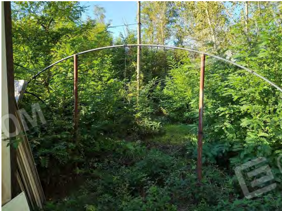
FOTO N. 12 – Altra vista con in primo piano i tubi dell'impianto di irrigazione
