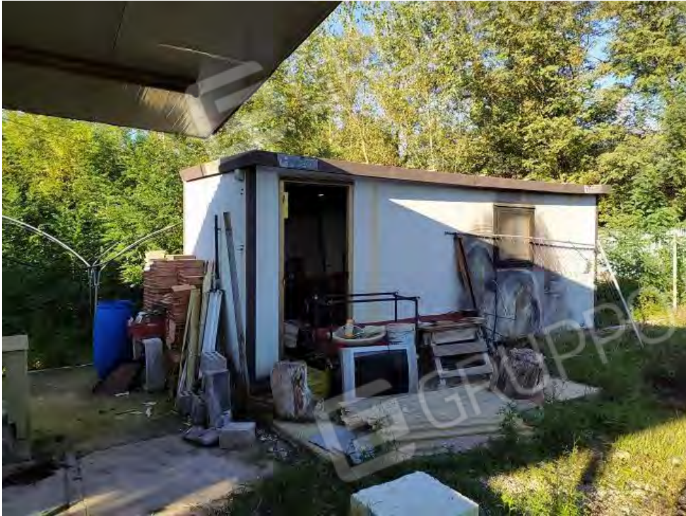
FOTO N. 5 – Vista del prefabbricato modulare
