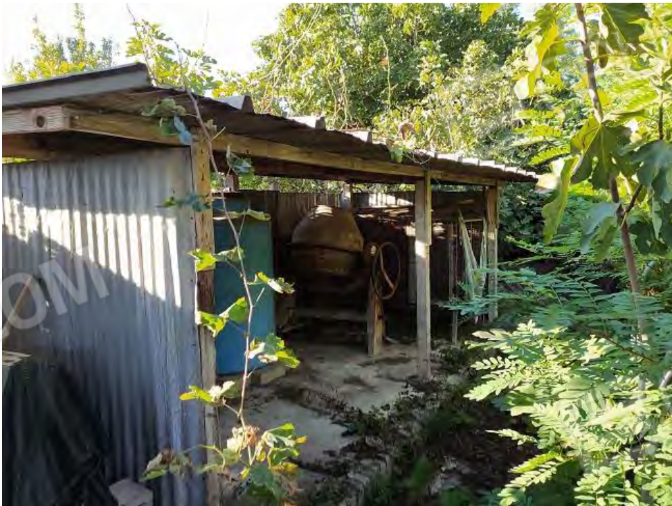
FOTO N. 6 – Tettoia in legno per il ricovero dei serbatoi di acqua
