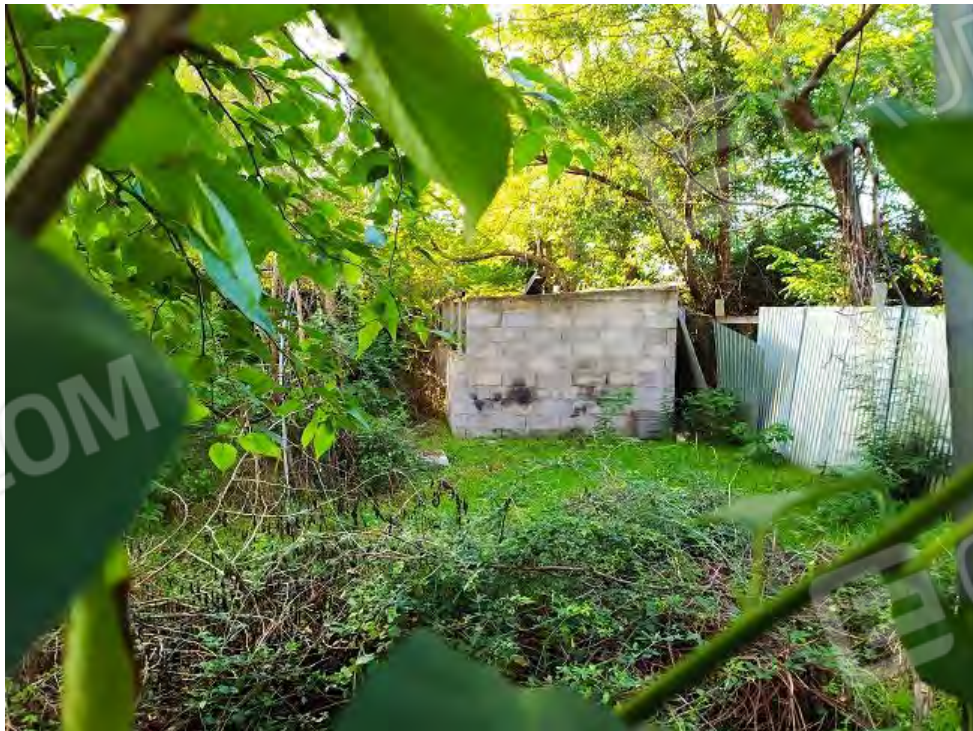
FOTO N. 14 – Manufatto presente sul confine Nord
