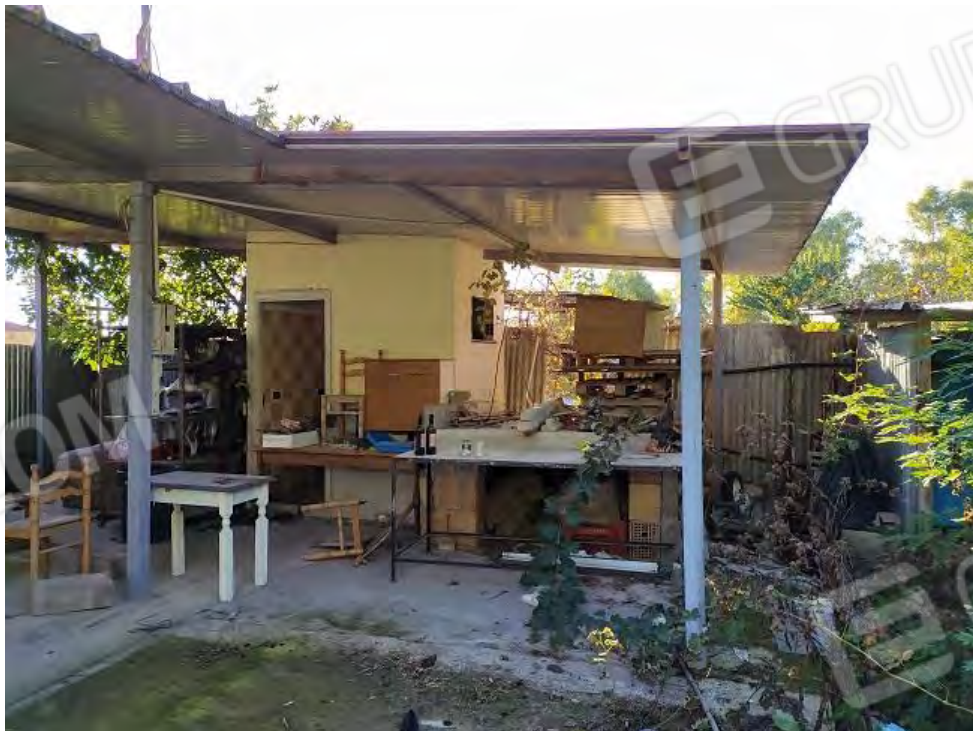
FOTO N. 8 – Tettoia posta nell’angolo Sud-Ovest con sottostante vano in muratura
