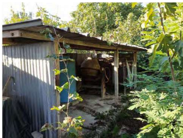
Tettoia per il ricovero dei serbatoi di acqua
