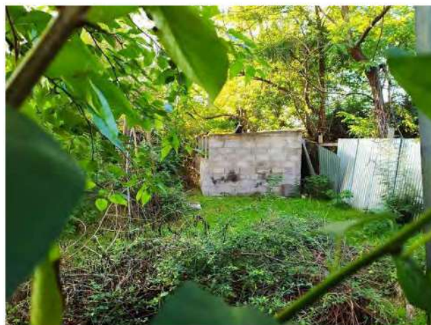
Manufatto già adibito a stalla o pollaio
