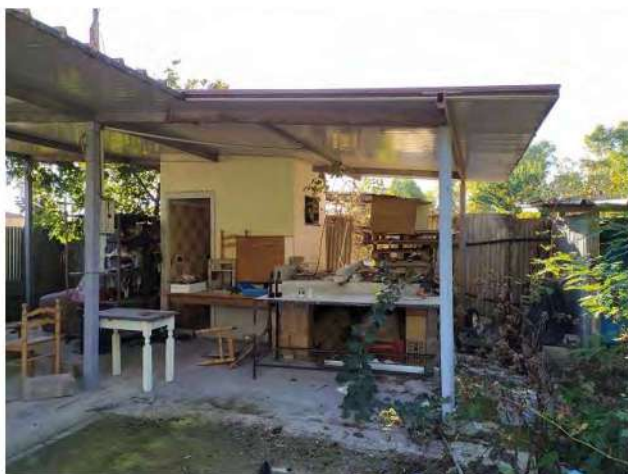
Tettoia con sottostante vano w.c.
