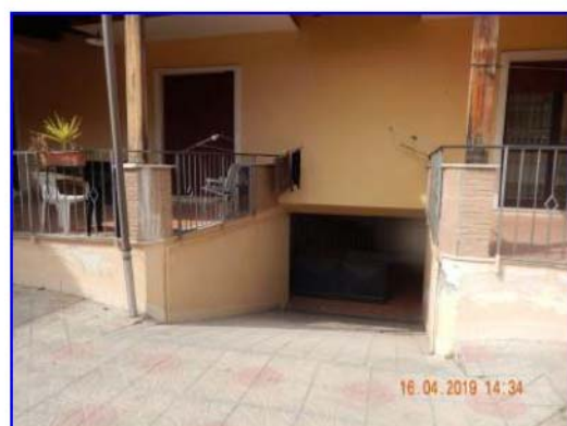
Immagine 3 – rampa di accesso al seminterrato
