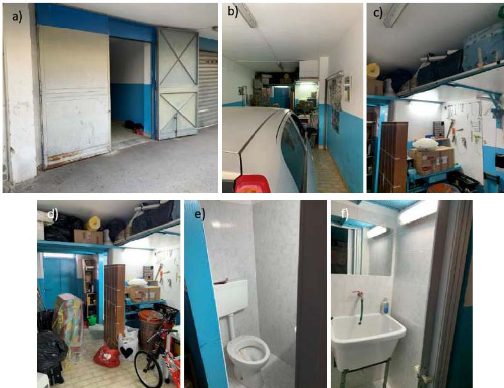
Figura 12: a), b), c), d) locale box auto; e), f) wc
