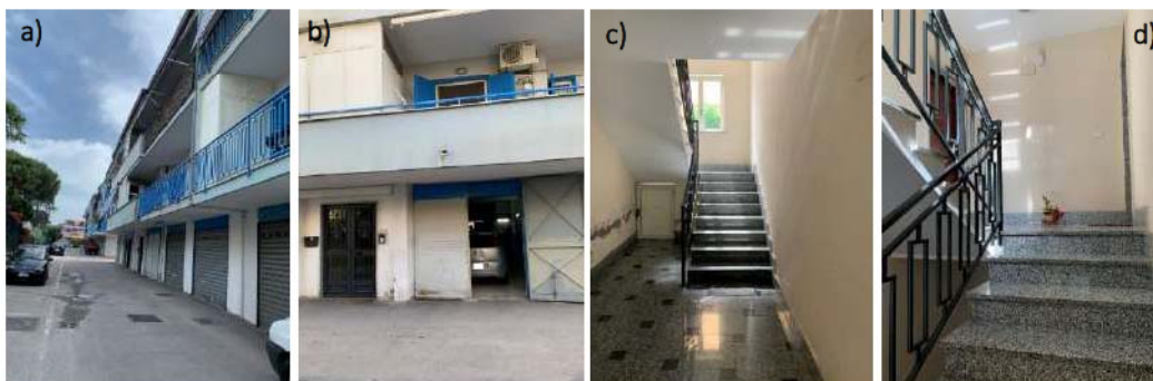
Figura 3: a), b) vista dell'ingresso al fabbricato; c), d) scala di accesso all'immobile
