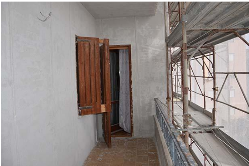
_balcone lato interno
