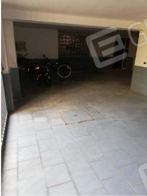
LOCALE DI SGOMBERO 1 S1
