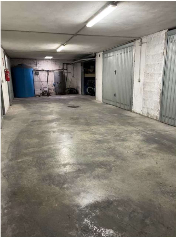
Fig. 21. Locale di sgombero esterno
