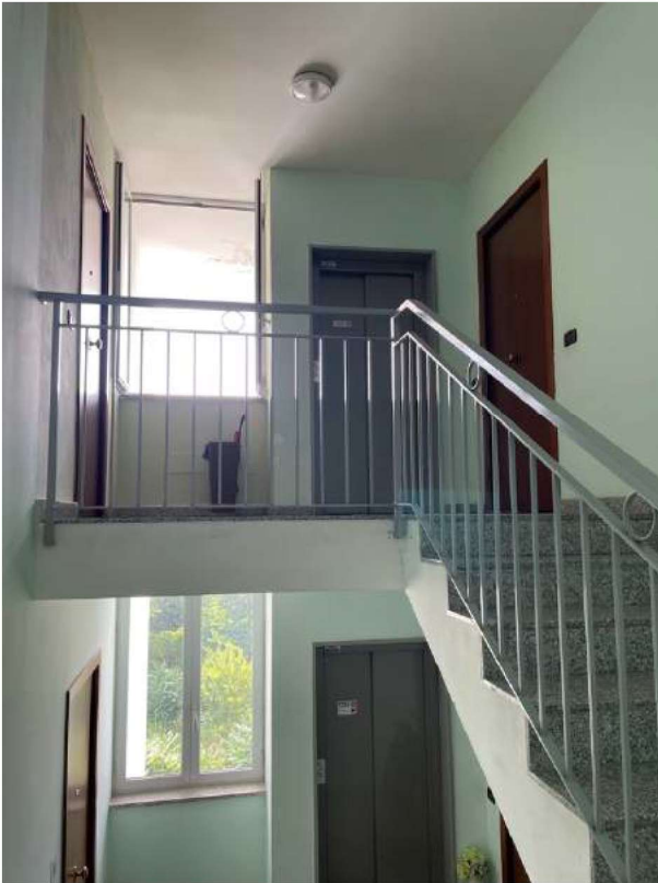
Fig. 7. Ingresso esterno abitazione
