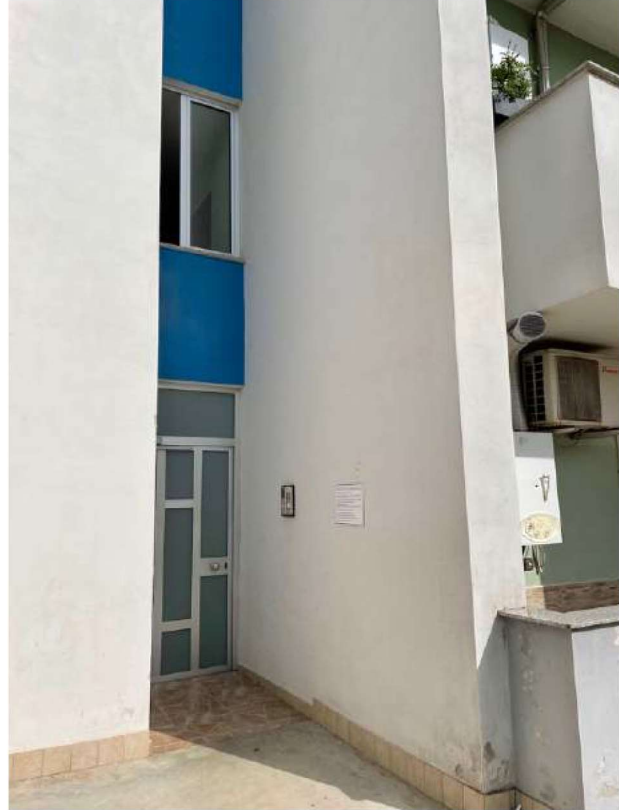
Fig.4. Ingresso pedonale (ovest)
