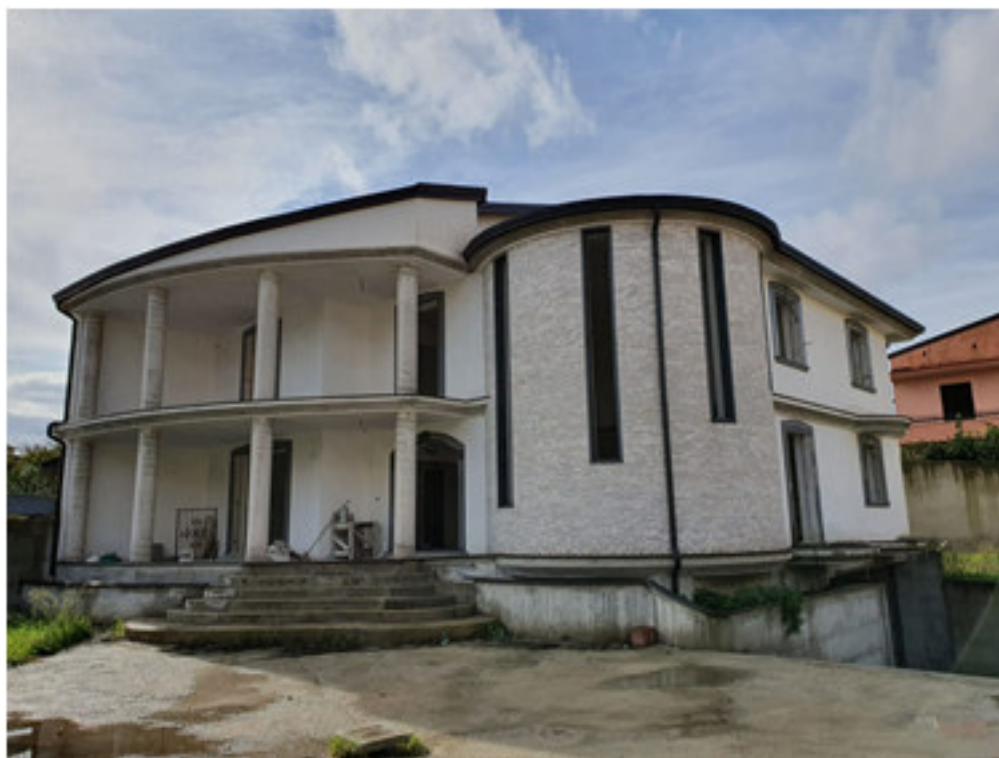
Villa in corso di costruzione
