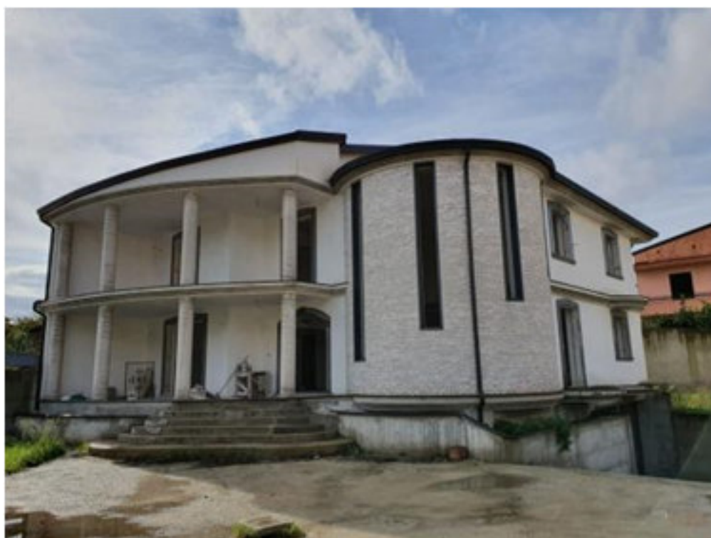
Villa in corso di costruzione
