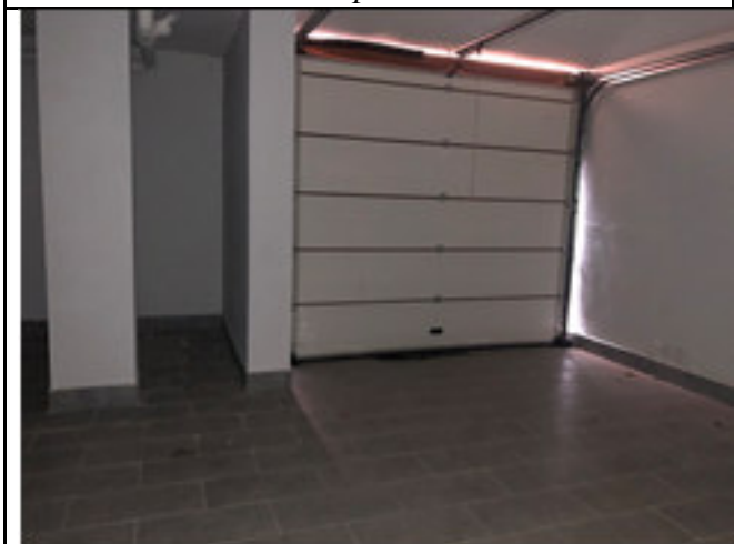
Autorimessa piano interrato
