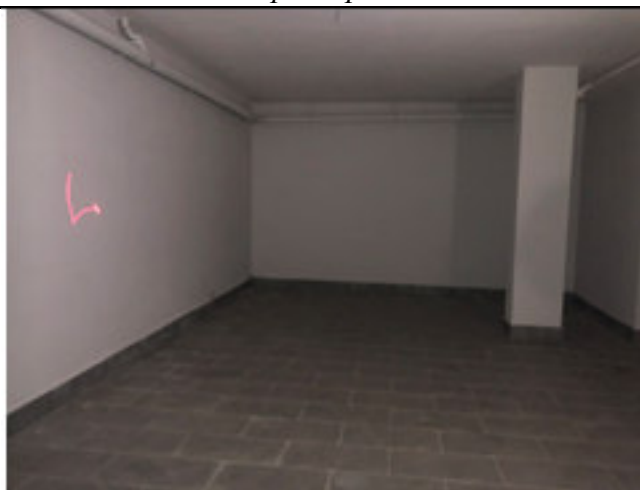
Autorimessa piano interrato
