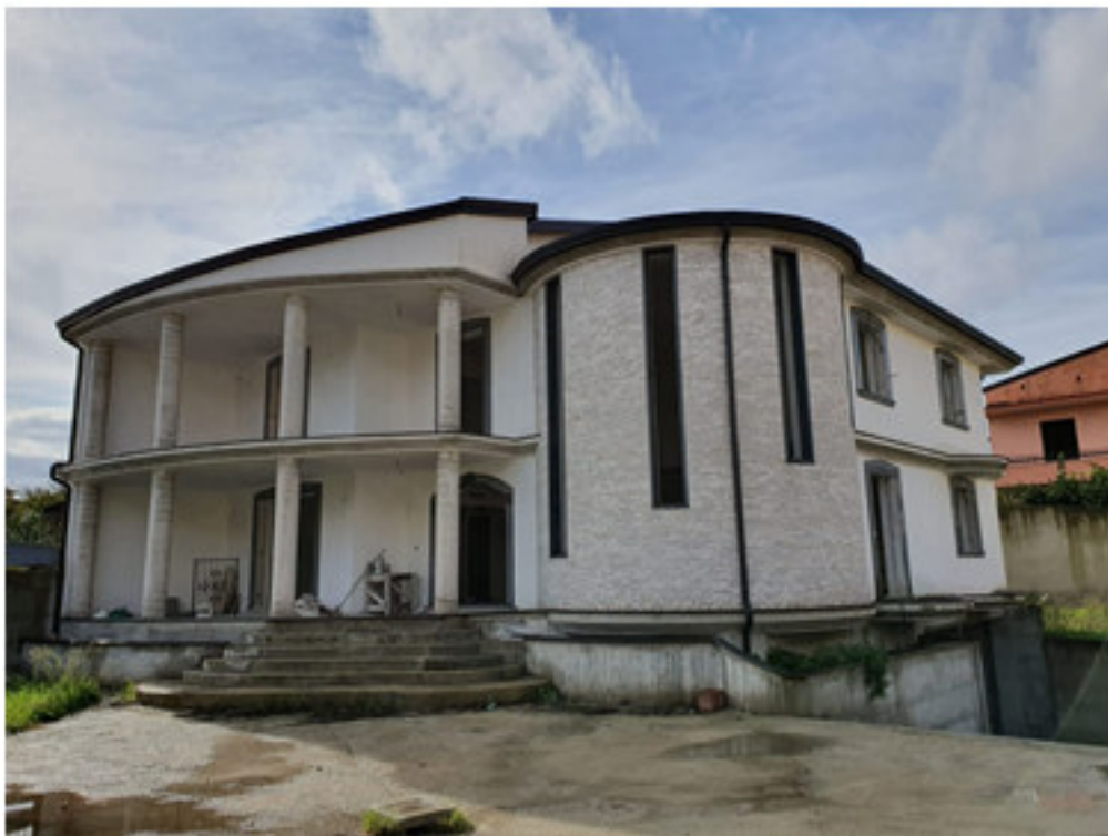
Villa in corso di costruzione
