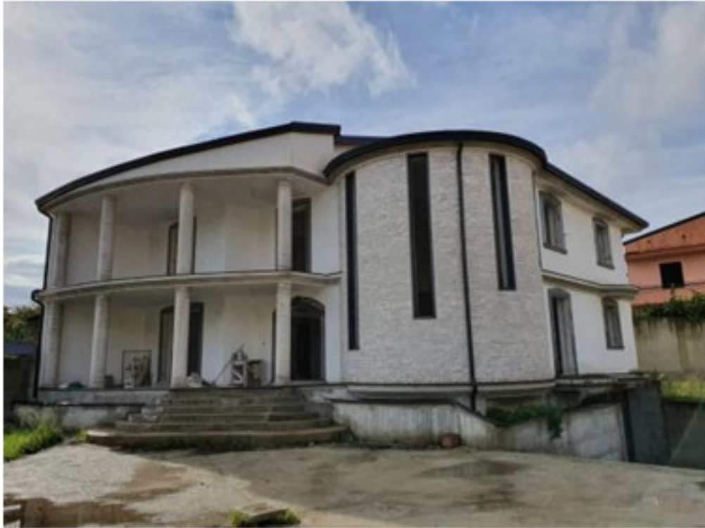
Villa in corso di costruzione
