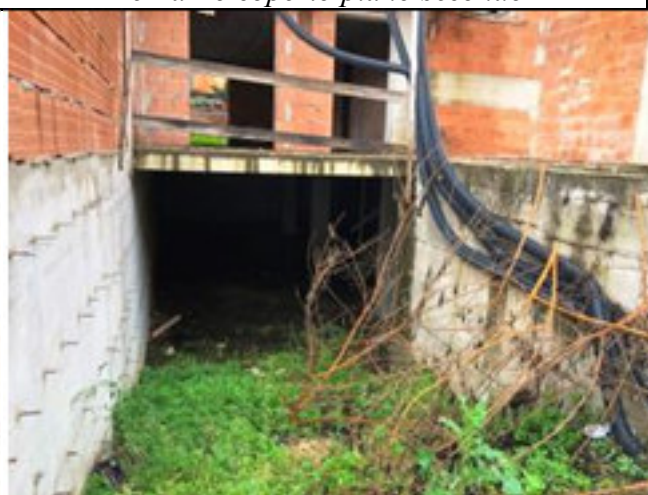
Rampa di accesso al garage
