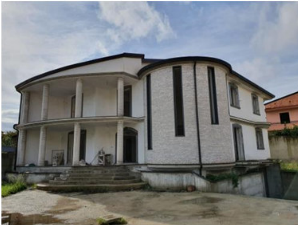
Villa in corso di costruzione
