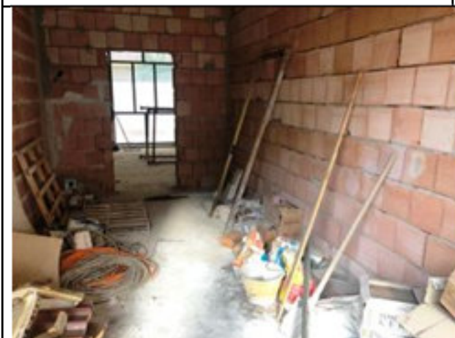
Interno sub locale lato O
