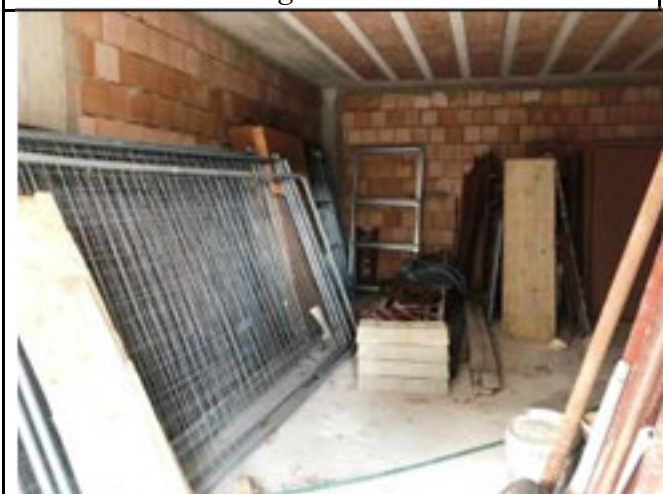
Interno sub locale lato E
