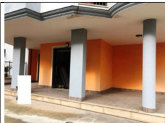
Vista esterna ingresso sub locale lato E
