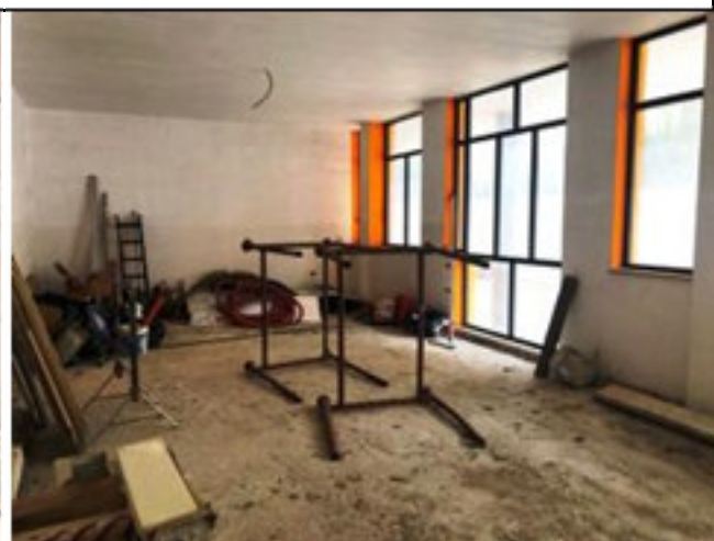
Interno sub locale lato O (lato cortile)
