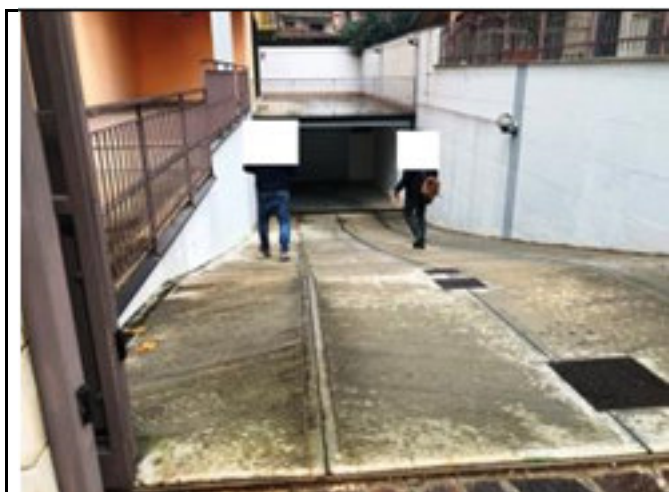
Rampa di accesso carrabile
