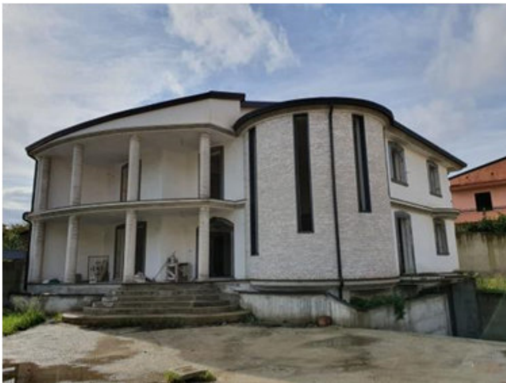
Villa in corso di costruzione
