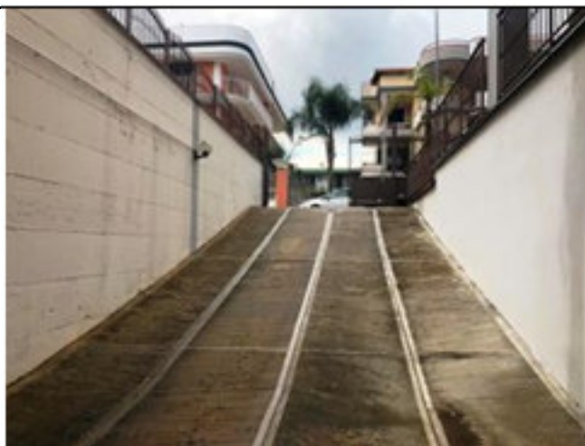
Rampa di accesso carrabile
