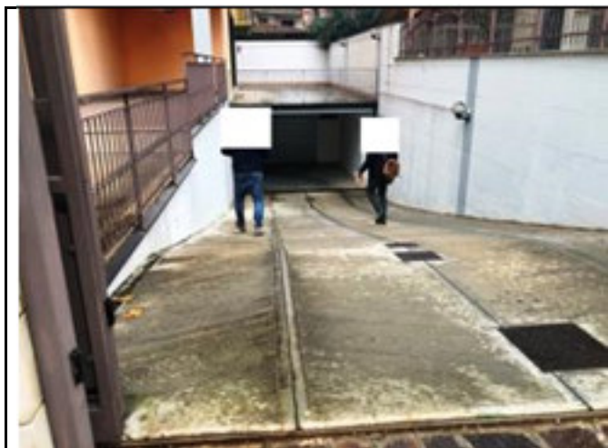
Rampa di accesso carrabile
