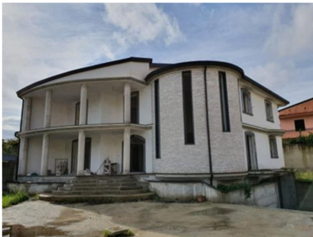
Villa in corso di costruzione
