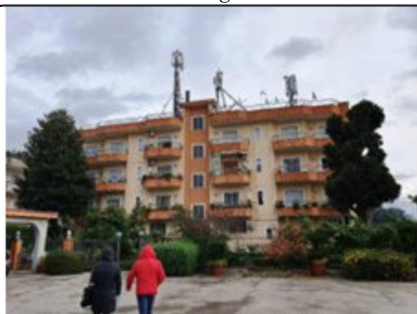
Vista del fabbricato
