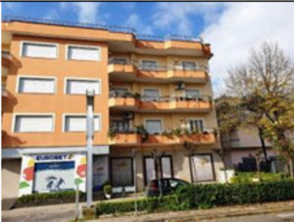
Vista esterna del locale
