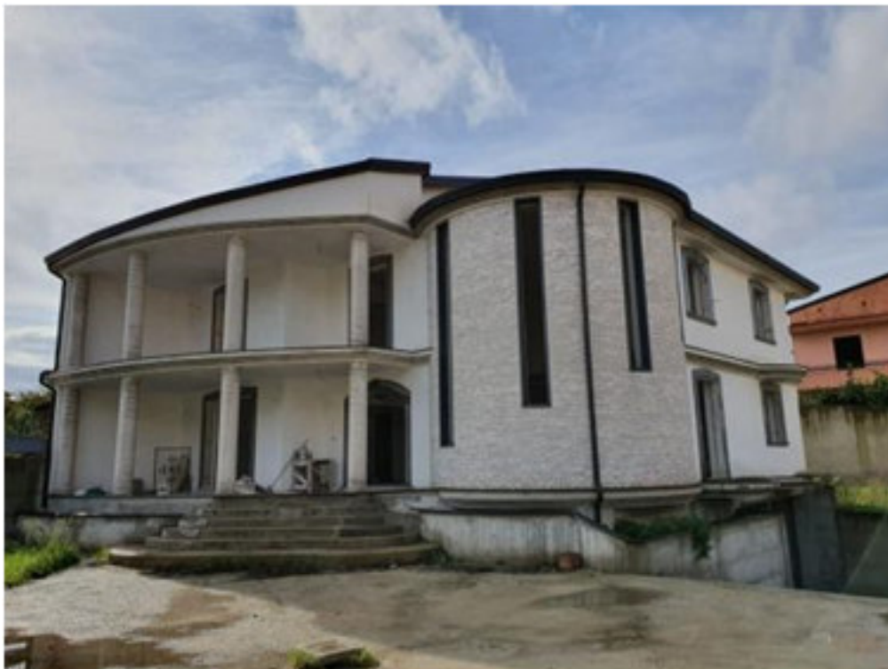
Villa in corso di costruzione
