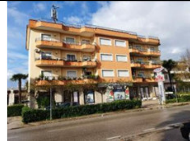
Vista esterna del locale
