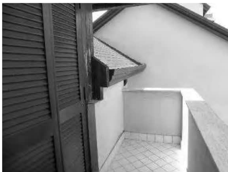
_camera 1 e balcone (lato ovest)
