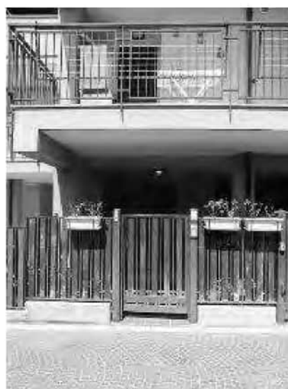
_immagine esterna del sub. 39 e accesso pedonale all'u.i.
