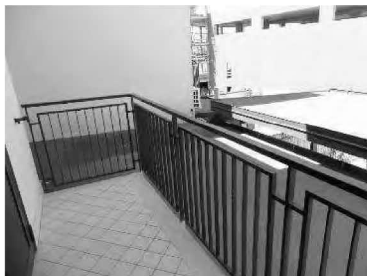
_balcone (lato ovest)
