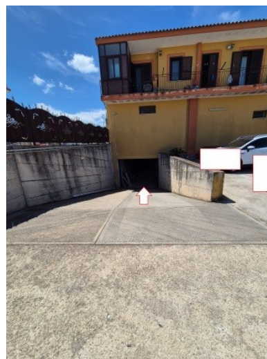
Figura 45 accesso carrabile al deposito al piano interrato
