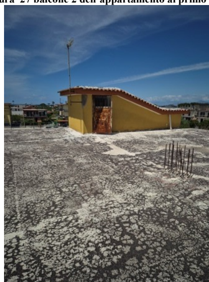
Figura 29 lastrico solare al secondo piano
