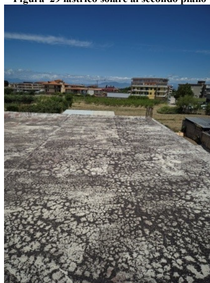
Figura 31 lastrico solare al secondo piano
