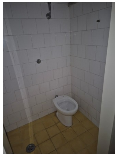
Figura 53 bagno del deposito al piano interrato
