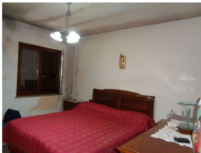
Particolare della camera da letto: macchie di muffa e condensa a soffitto e a parete
