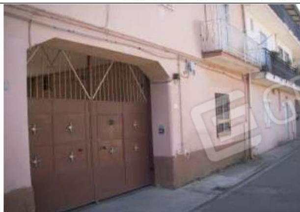
(foto 1: portone lato strada)
