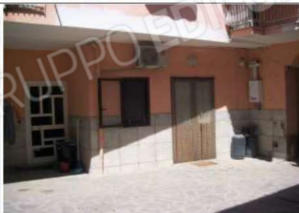
(foto 2: portoncino d'ingresso)
